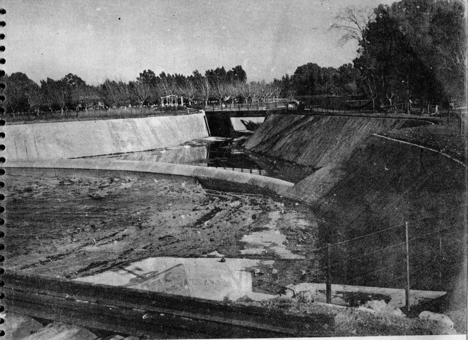
Canalización de los arroyos Maldonado y Napostá en Bahía Blanca
