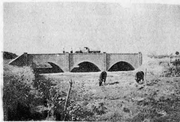
Puente sobre cañada de Chivilcoy
