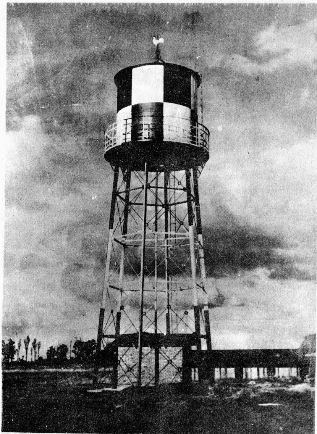
Tanque distribuidor de agua para la Fabrica de tejas y macetas de Gorina.-
