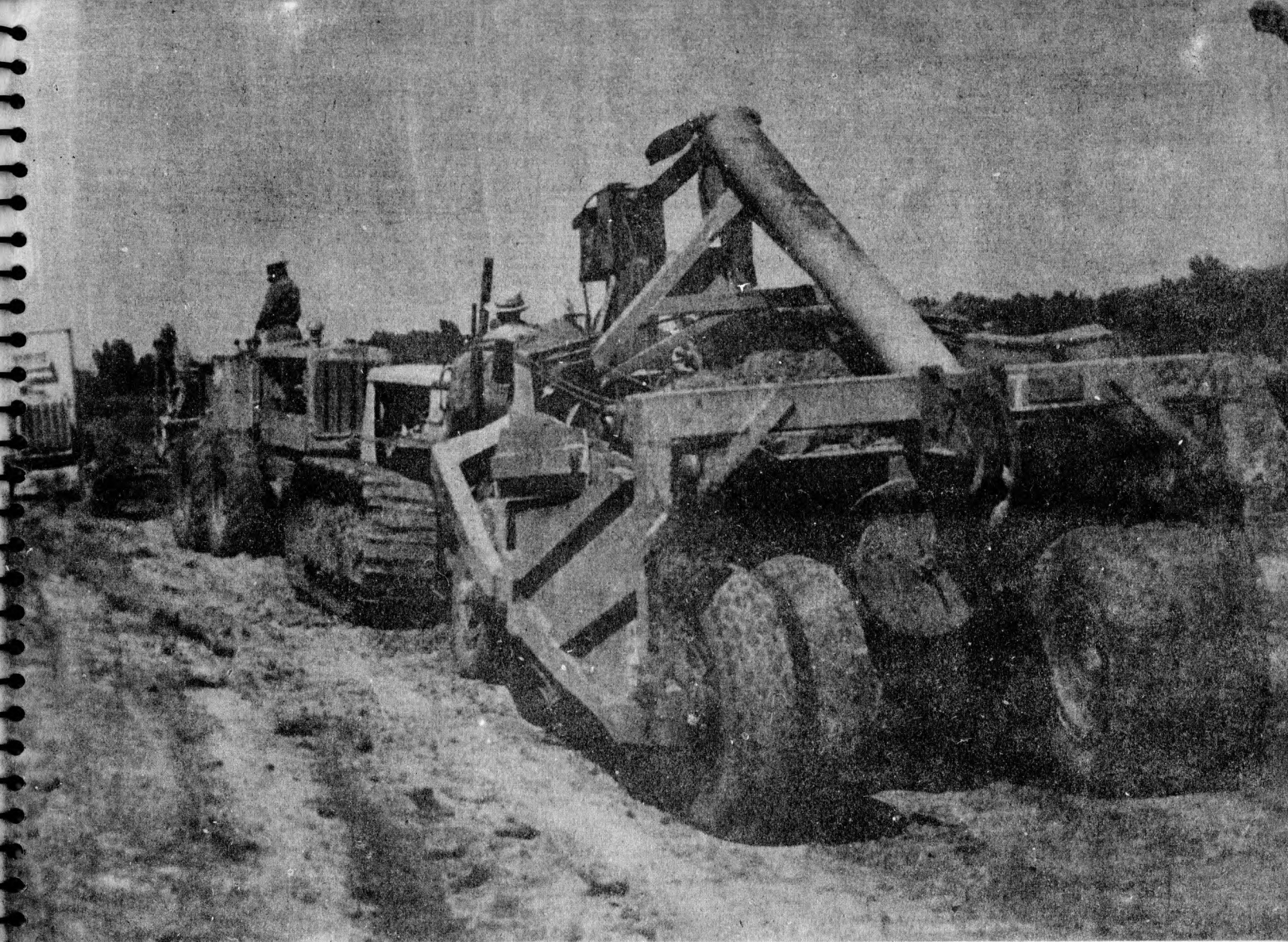
Tractores Topadores y Motoniveladora en operación
