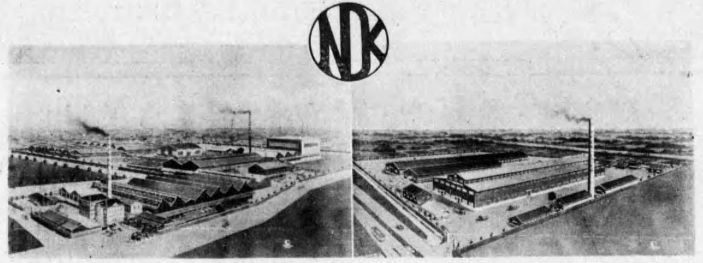
向島工場 川崎ケーブル工場
