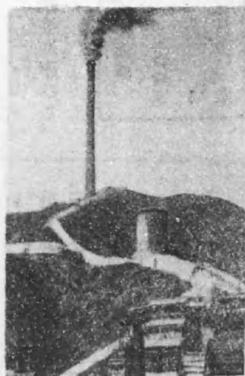
〔第九七圖〕 日立鑛山の煙道及び煙突
