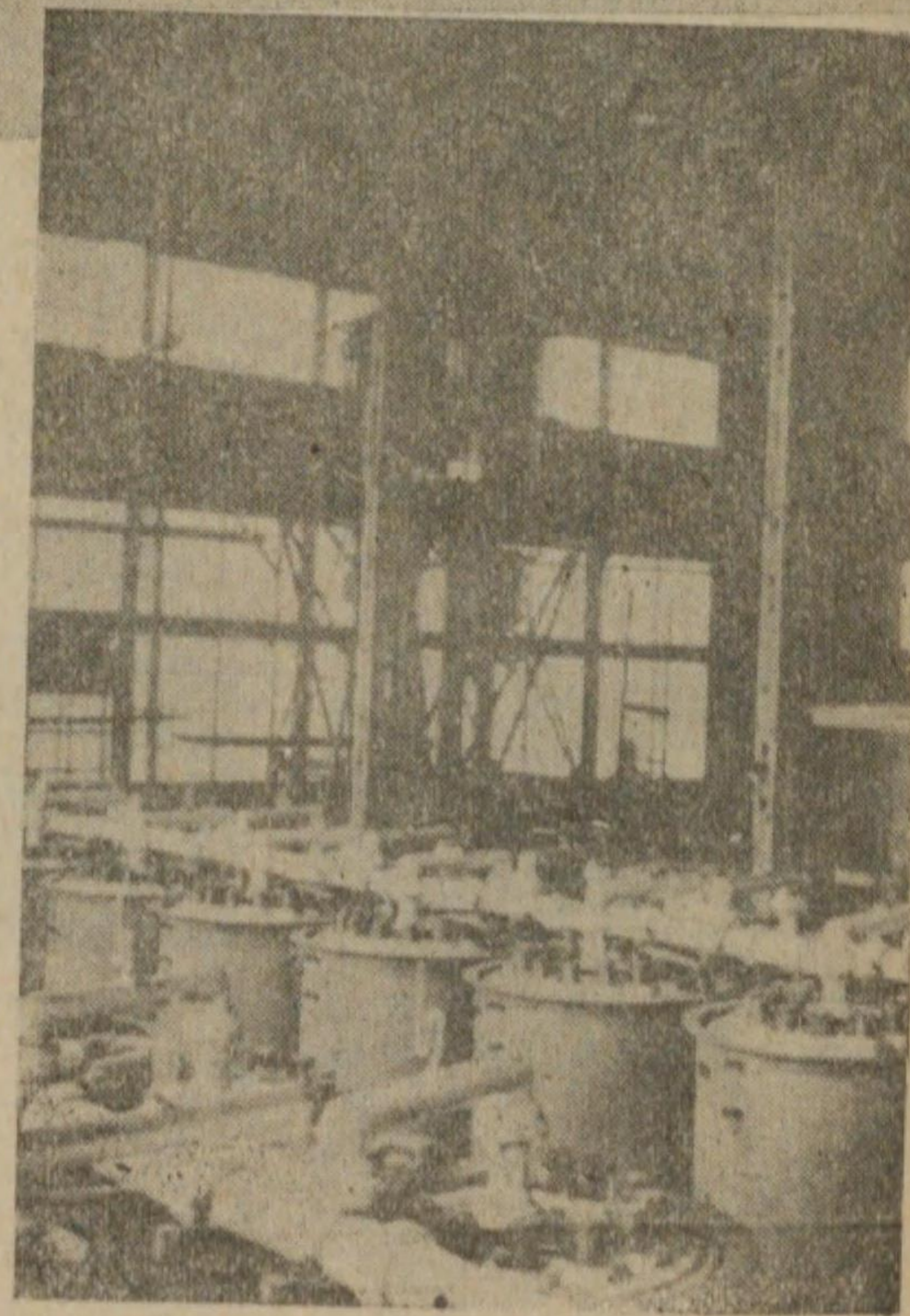
日東式豎型隔膜鹽水電解槽
