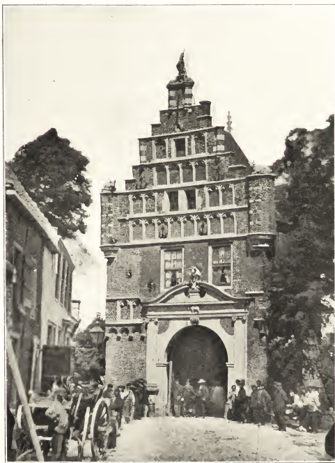
Afb. N o . 49. Hoorn, de Kooppoort gezien van de stadzijde, naar een photo.
