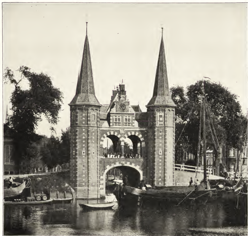
Afb. N o . 78. De Waterpoort te Sneek na hare restauratie, gezien van de buitenzijde. Naar een photo.
