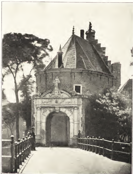
Afb. N o . 50. Hoorn, de Koepoort gezien van de buitenzijde, naar een photo.
