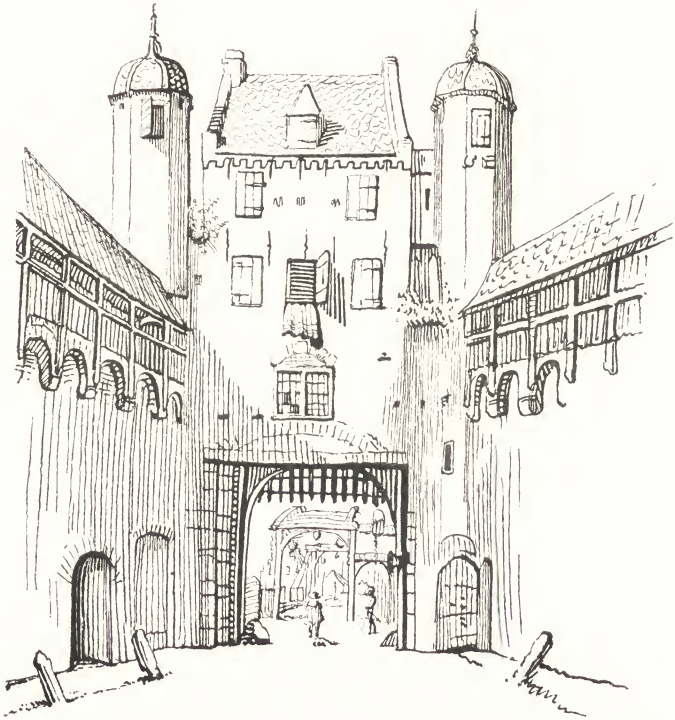
Afb. N o . 58. Zwolle, de Camper-voorpoort van de binnenzijde gezien, naar eene teekening van G. Terborch ± 1630.
