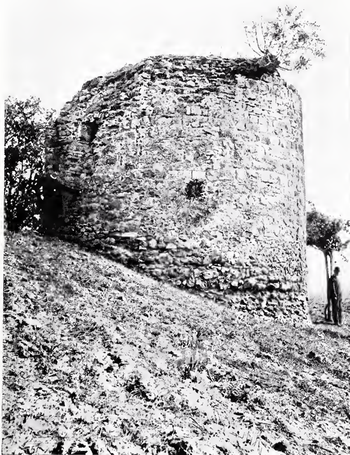
RUDERO DI TORRE PRESSO CASTIGLIONECELLO.
