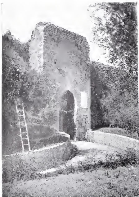
MONTERIGGIONI — LA PORTA DI LEVANTE DALL' ESTERNO.
