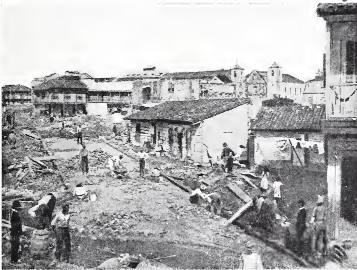
PAVIMENTAZIONE DI UNA STRADA A PANAMA.
