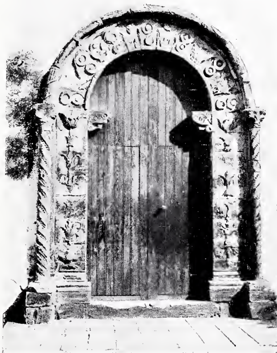
SAN MARTINO — FORTE SETTENTRIONALE.
