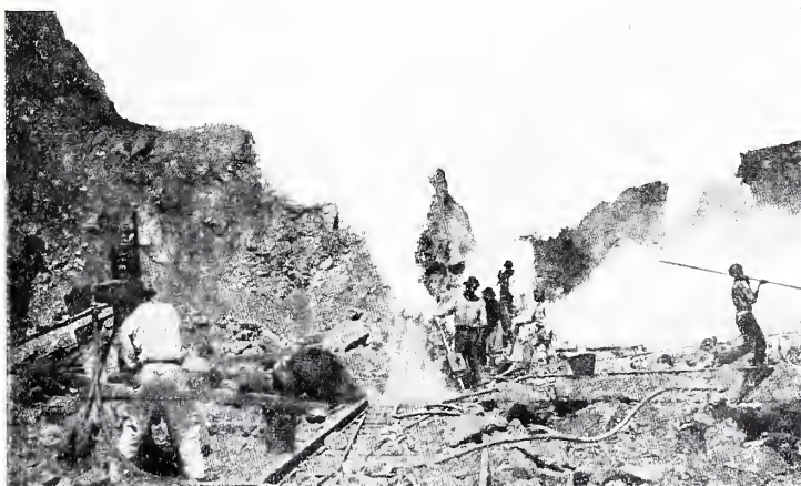
PERFORATRICI A VAPORE IN OPERA A BAS OBISPO.
