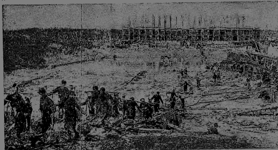
▲ 蘇家壩建閘工地上，工人和民工親密合作，使工程進展很快。這是常德二總隊民工，在緊張地清理閘壩和趕修新堤。
