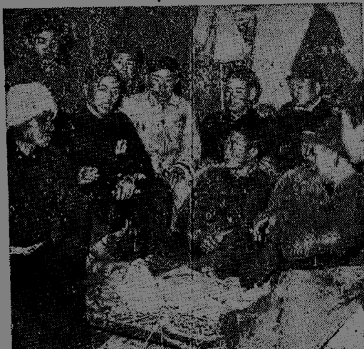
▲ 春節中，省和專區以及廣大的後方，都派了慰問團來到工地。這是蘇家壩華鄉的代表到建該鄉第四聯組工棚後，民工們都圍攏來，聽親人講述家鄉的生產和生活情況。
