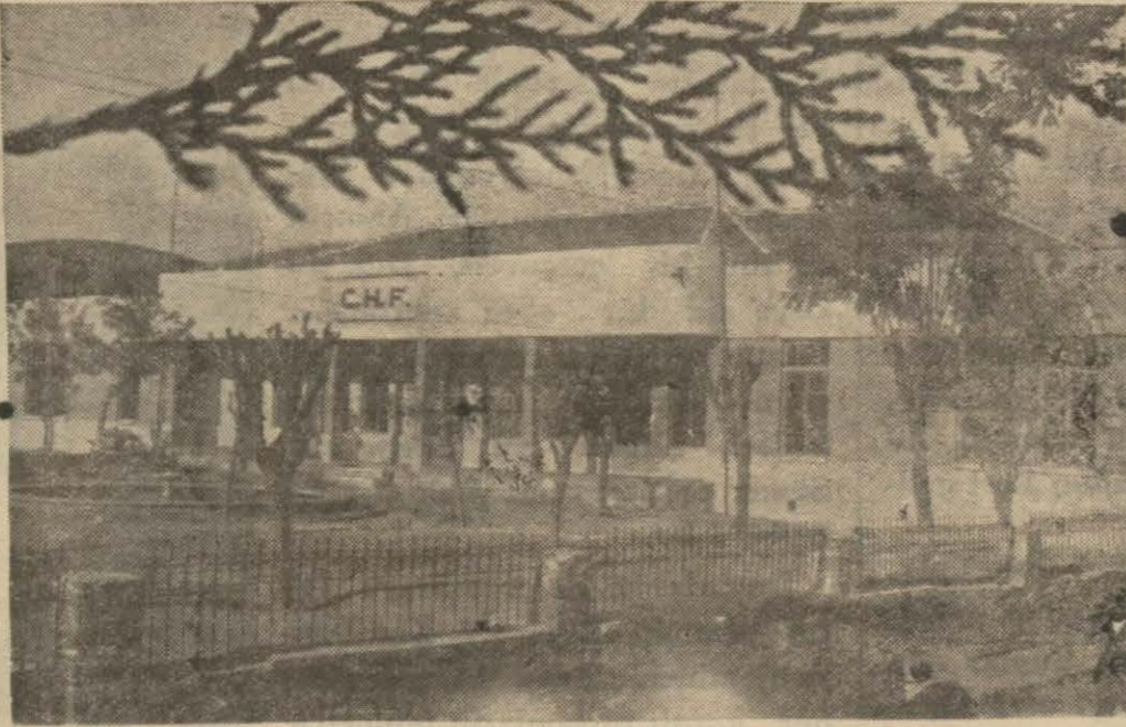
Bergamada Parti ve Halkevi binası
