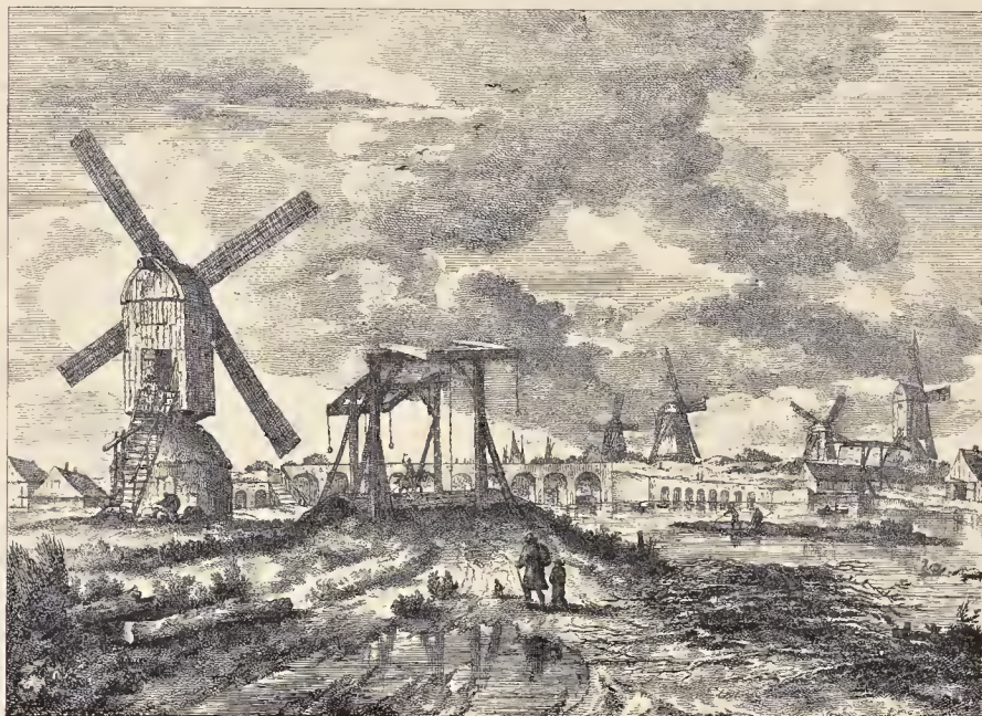
DE HOOESLUIS VAN DE STADS-ZIJDE GEZIEN, VOOR DEN AANLEG VAN DEN BINNEN-AMSTEL (1662)
