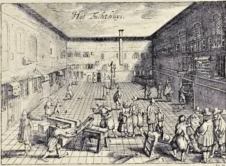
BINNENPLAATS VAN HET RASPHUIS
