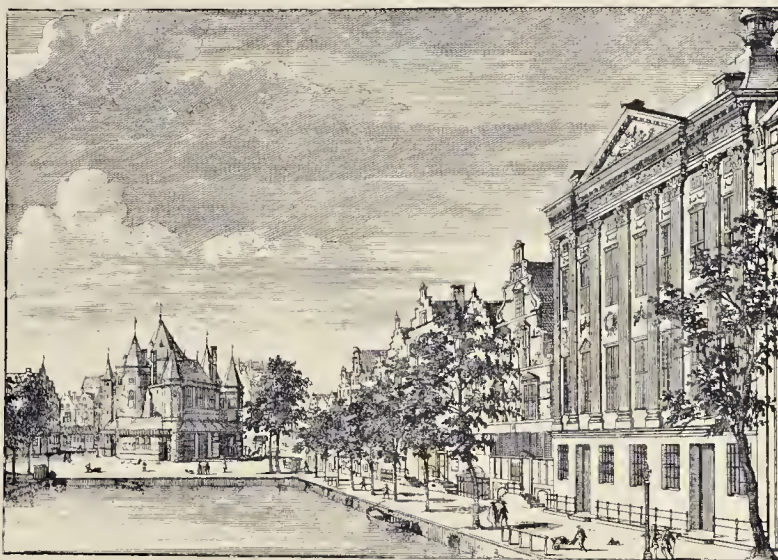
NIEUWMARKT EN TRIPPENHUIS
