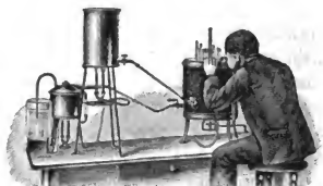
Fig. 2. Justieren von Thermometern unter 100 Grad.
