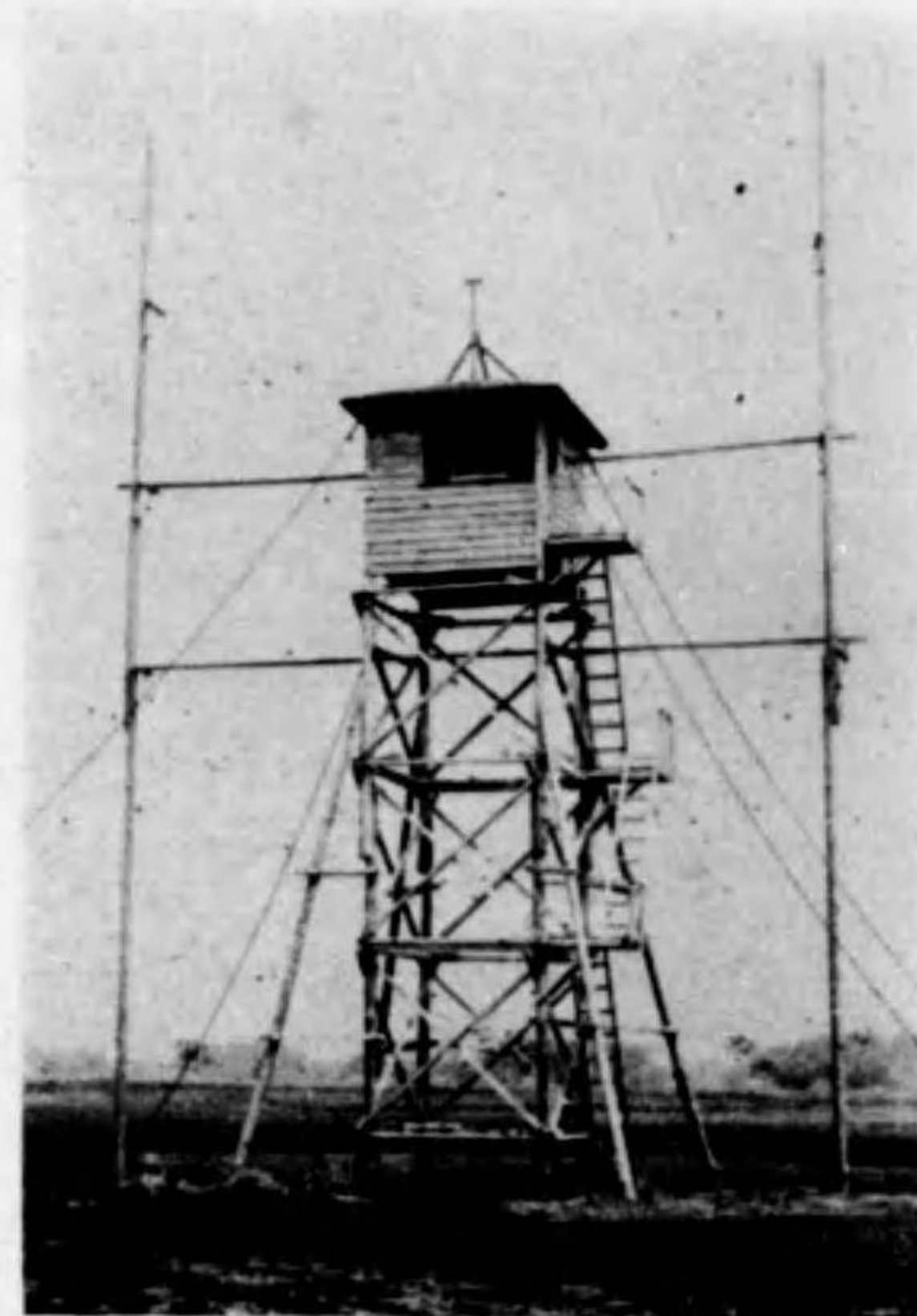
第 11 圖 入射角測定用塔
