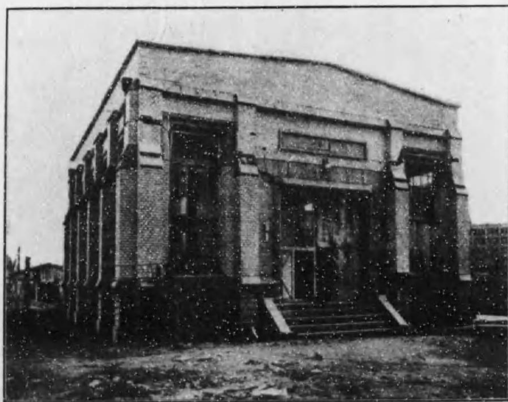
常盤橋變壓所正面の被害
