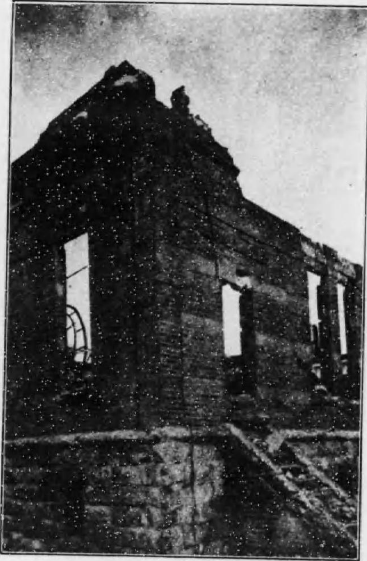
有樂町變壓所西南隅の被害
