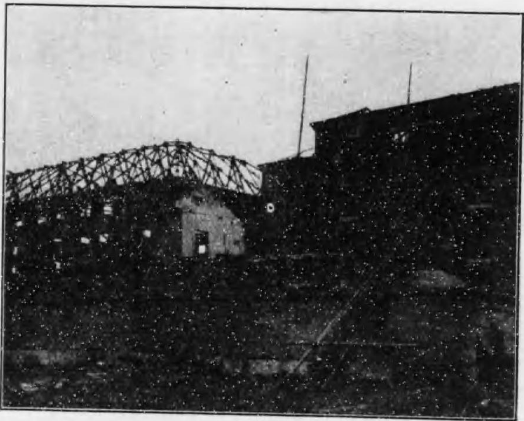
下谷變壓所一部の被害
