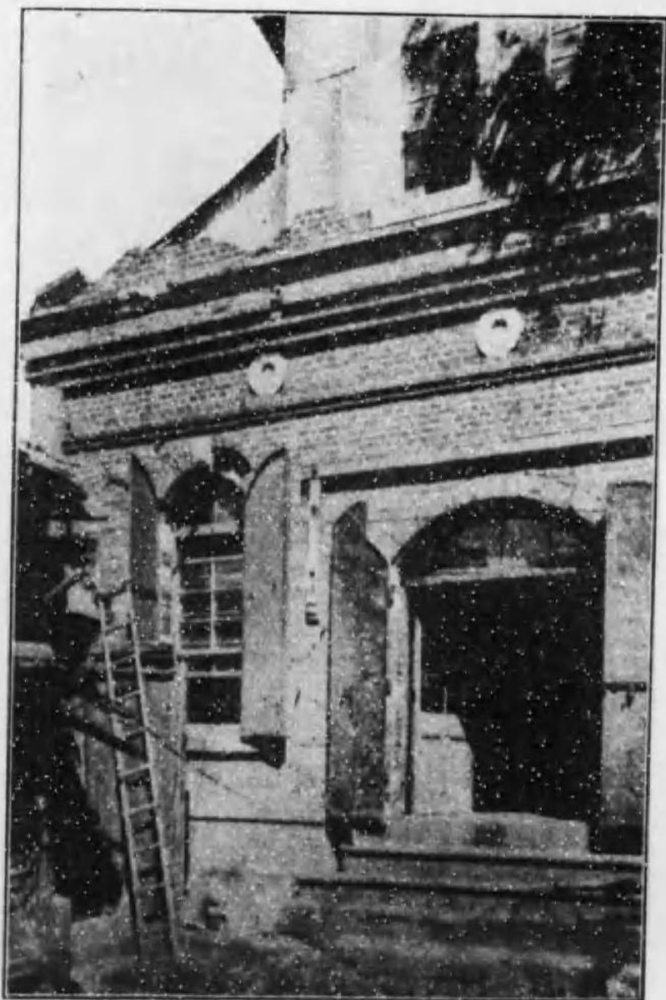
忍町變壓所一部被害
