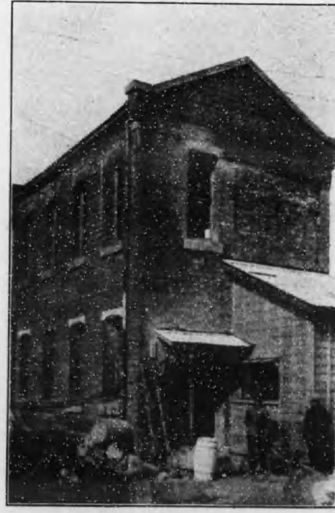
飯田町開閉所の被害
