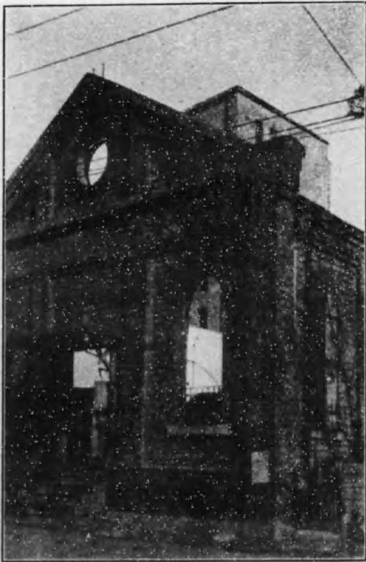
八官町變壓所の被害
