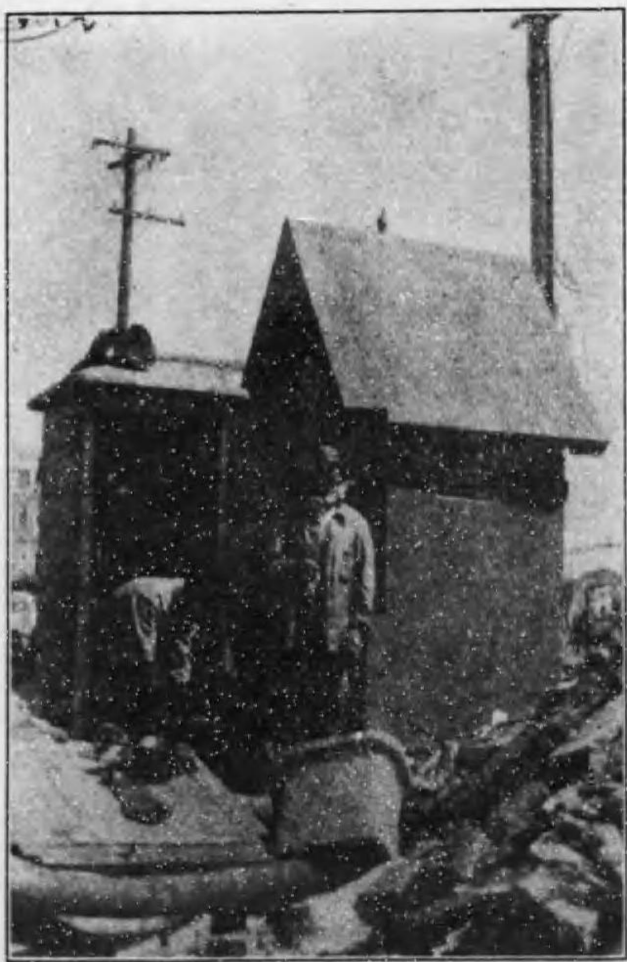
(イ) 鐵板製變壓塔の被害
