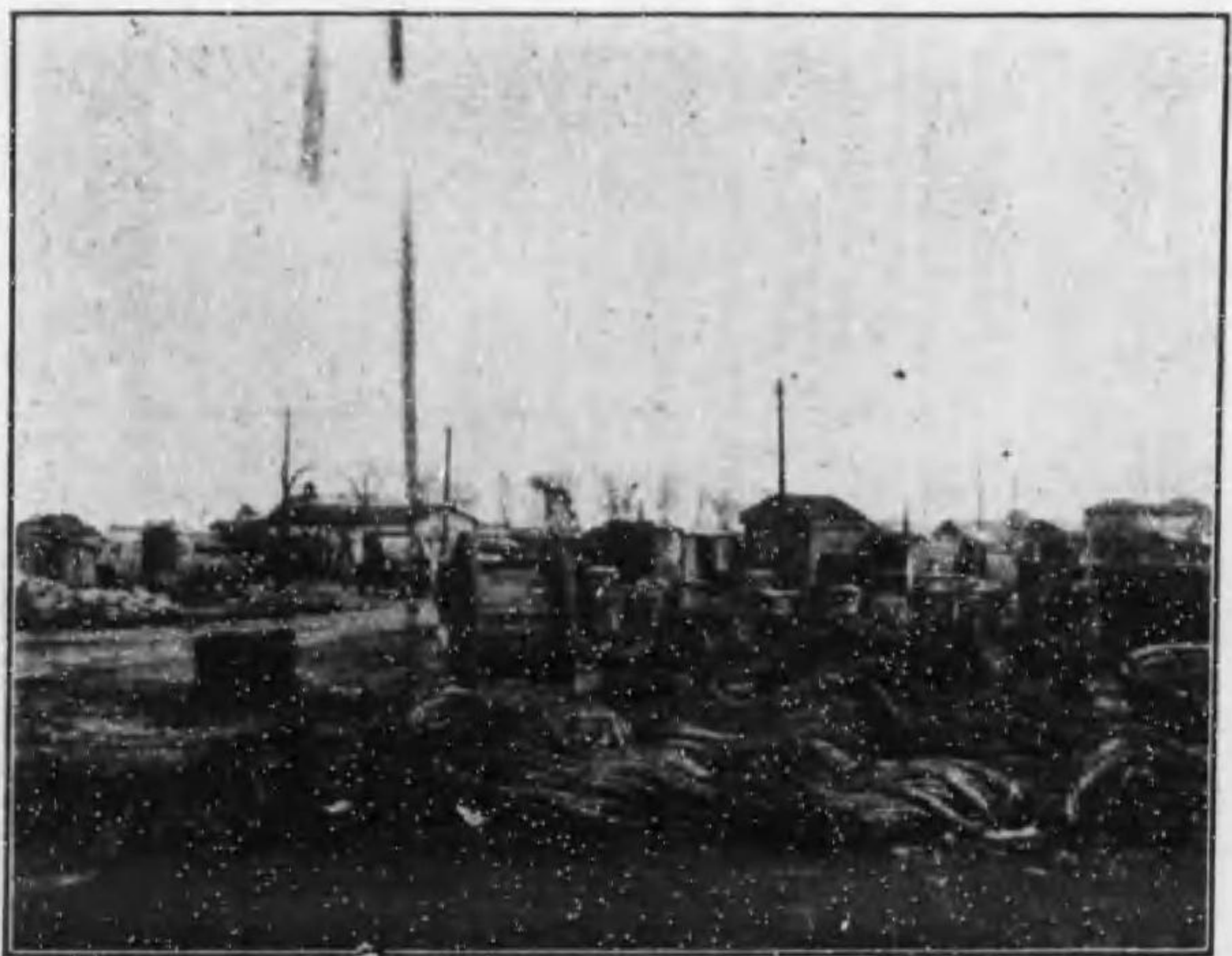
芝崎町建設所の被害
