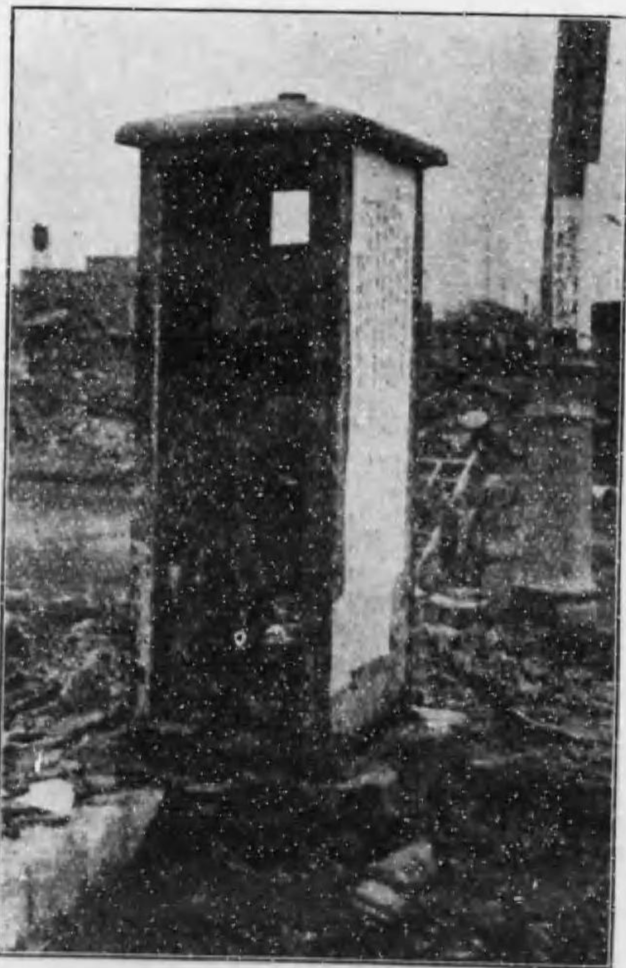
(ロ) 煉瓦製(高さ八尺、長さ六尺巾四尺) 鐵板製(高さ七尺、二尺五寸方形) 鐵板製變壓塔の被害
