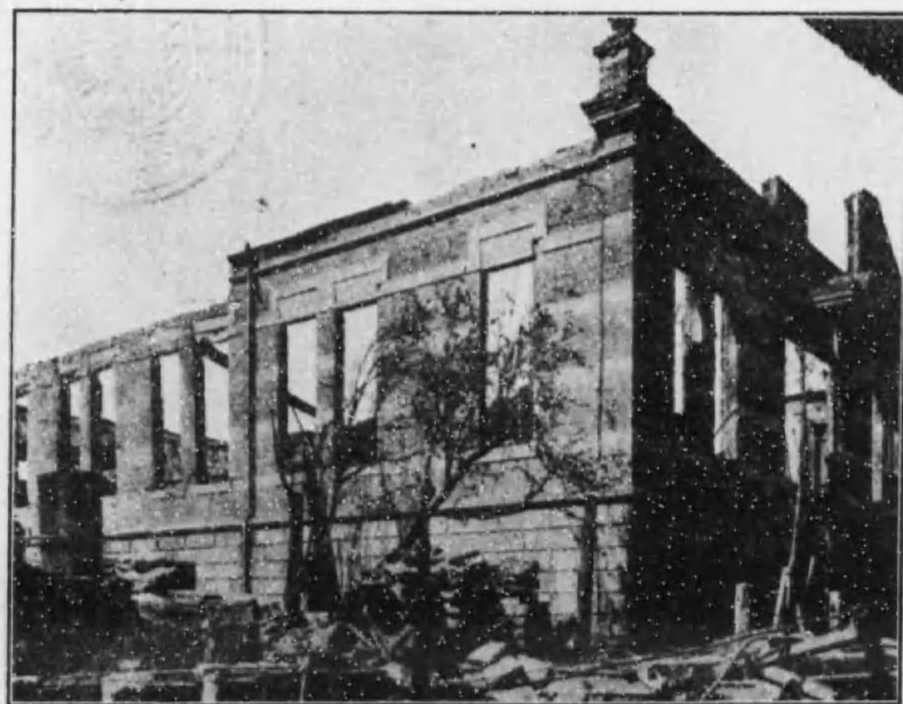
有樂町變壓所正面被害
