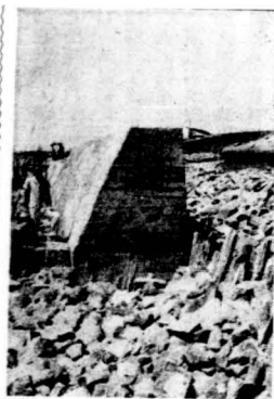
(六) 夾石混凝土牆已完成之情形
