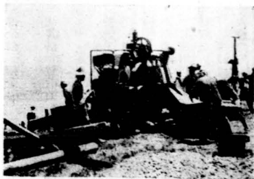
情形土凝混拌機 (三)
