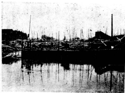
日潭港水閘建造工程全景→
