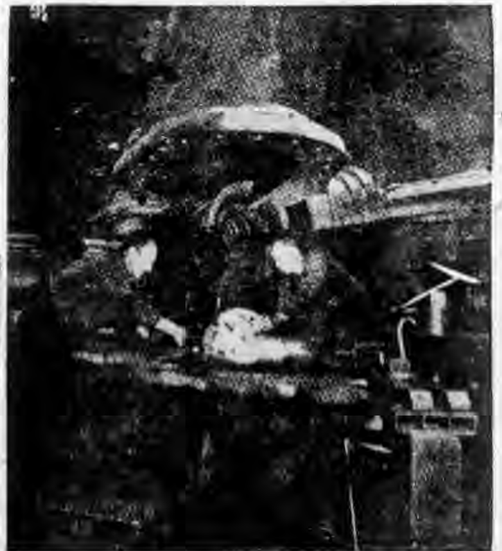
(第十圖) 10,000瓩透平的高壓節
