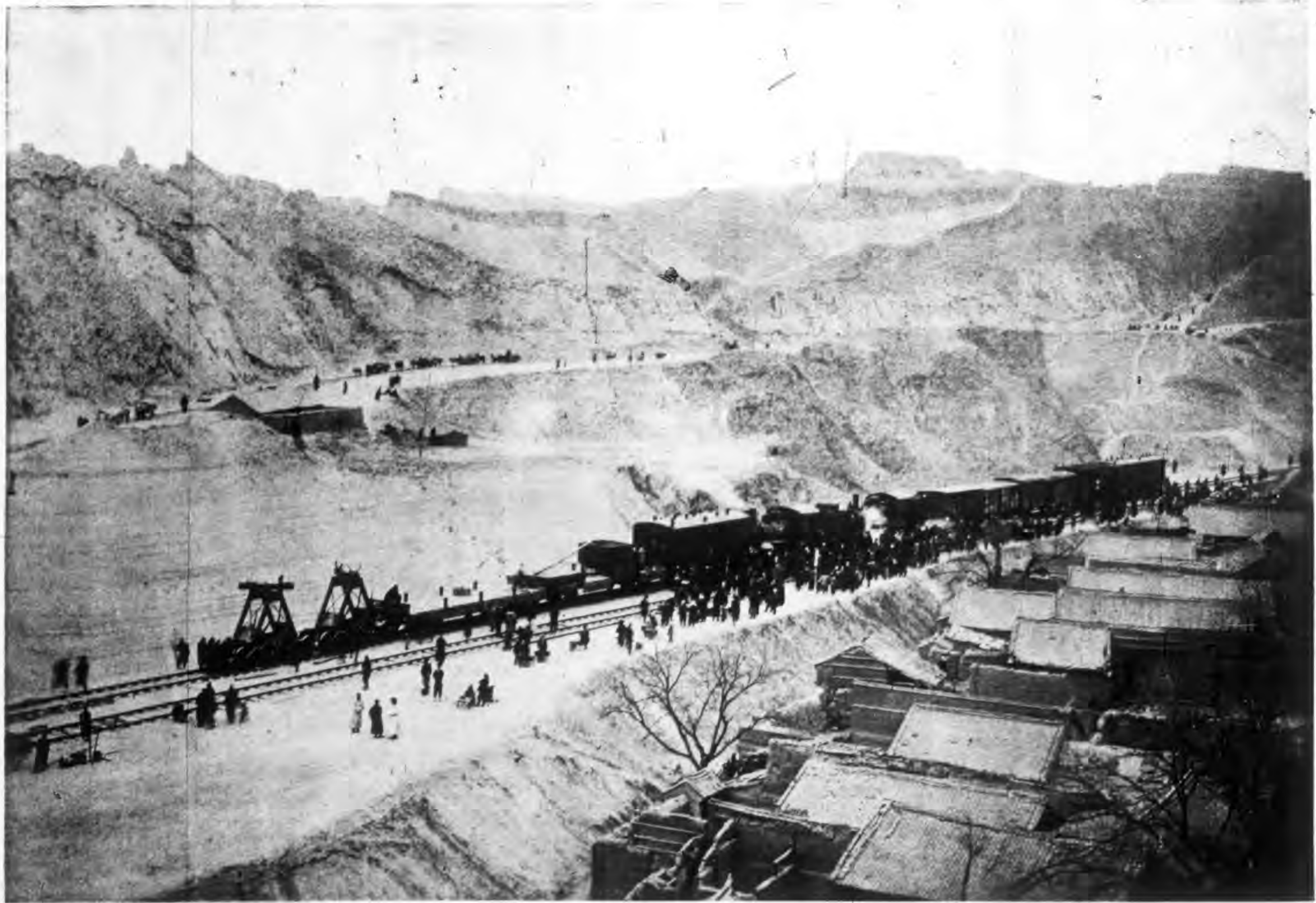
本路靈寶至潼關一段新工於二十二年二月粗竣此為車通潼關時攝影
