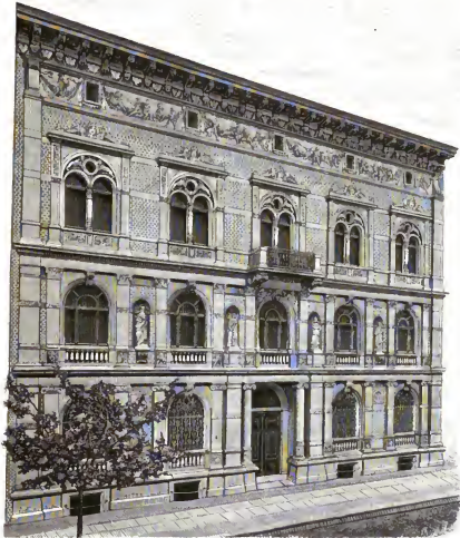
Die Weininger Haus, erbaut von Gude und Schwan.
