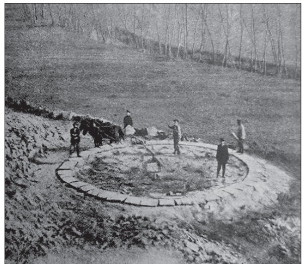
Шліфування плит. Село Русава (нині Ямпільського району Вінницької обл.). Фото початку 20 ст. За виданням «Кустарные промыслы Подольской губернии».
