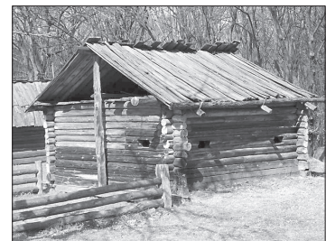
Дерев'яна хата із с. Біловіж (нині Рокитнівського району Рівненської обл.). 1697. Національний музей народної архітектури та побуту України. Фото 2011.
