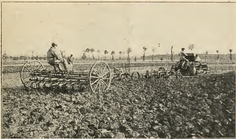
Fig. 49. — Tracteur II I de Renault trainant une charrue, un cultivateur et une herse à dents flexibles
