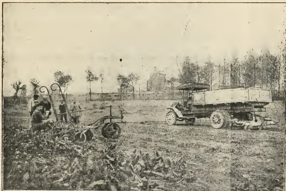
Fig. 79. — Arrachage des betteraves avec le camion-treuil Hour et Amann.
