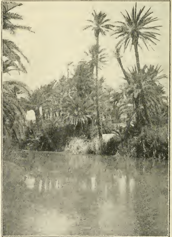
Fig. 29. — Oasis du Tiout : barrage distribuant l'eau à toute l'oasis.
