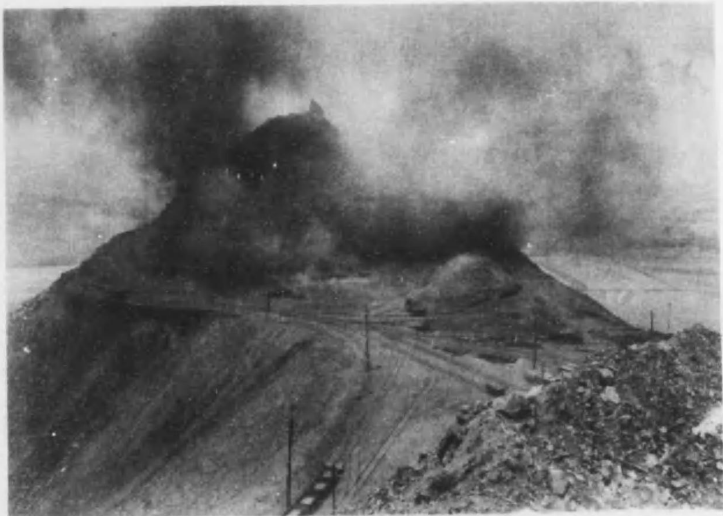
大孤山の爆破作業
