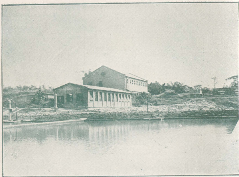
新水廠高壓抽水機及發電機房外觀
