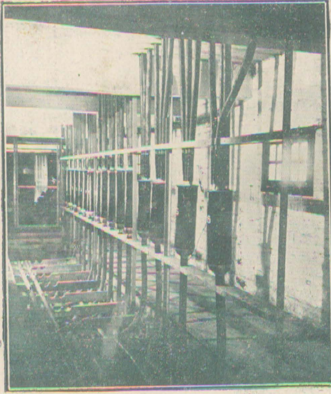
藏地電纜與總所內部電纜之接駁
