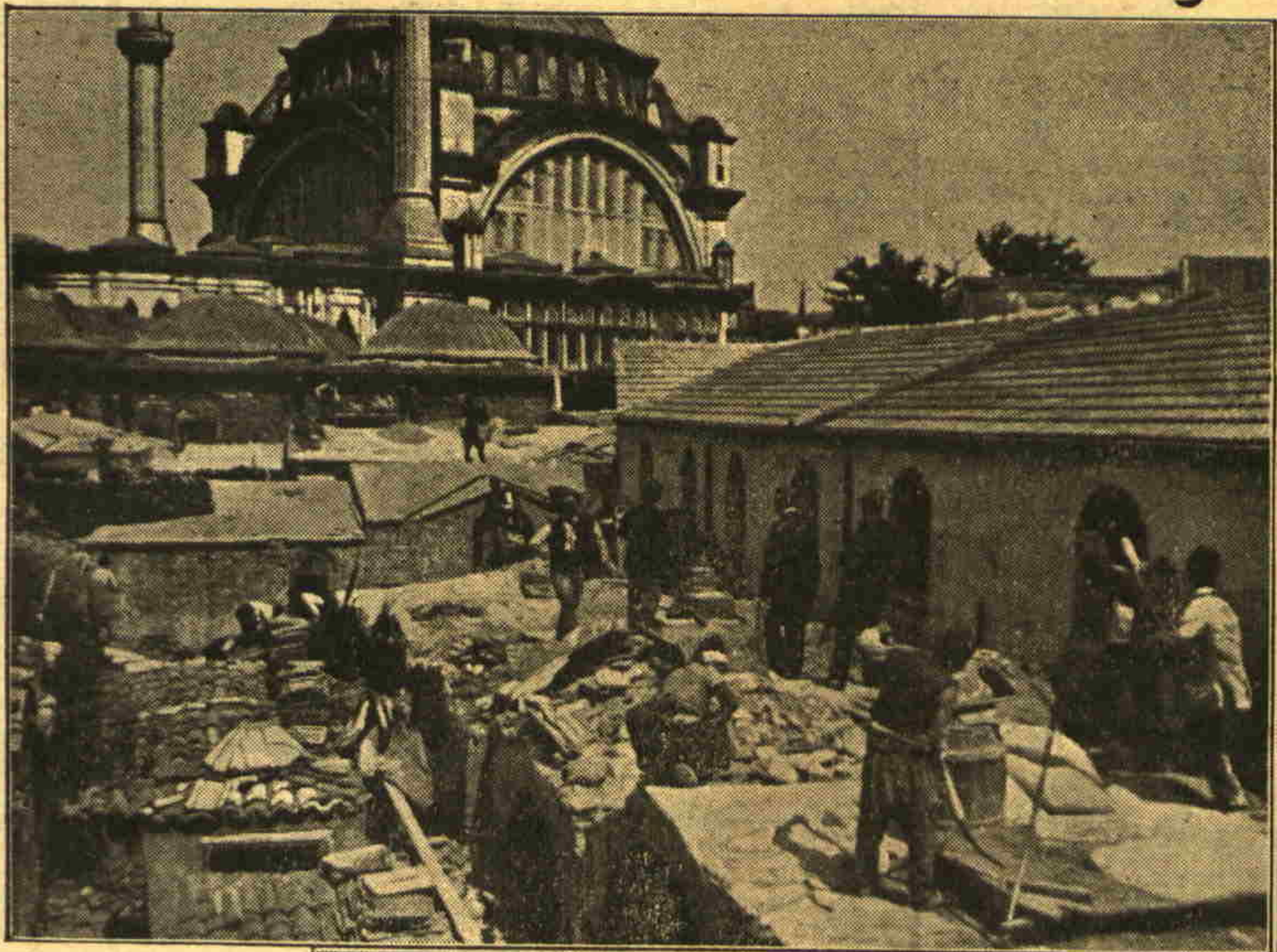
چارشوی کبیره دکانلرک اسکی دامیله یکی دام و منفذلری [ خصوصی فوٹوغرافیلر مزدن ]
