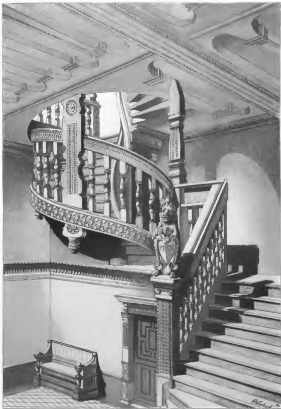
Fig. 19. Treppe im Schenkischen Hause zu Bruttig.
