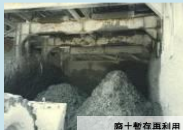
廢土暫存再利用
