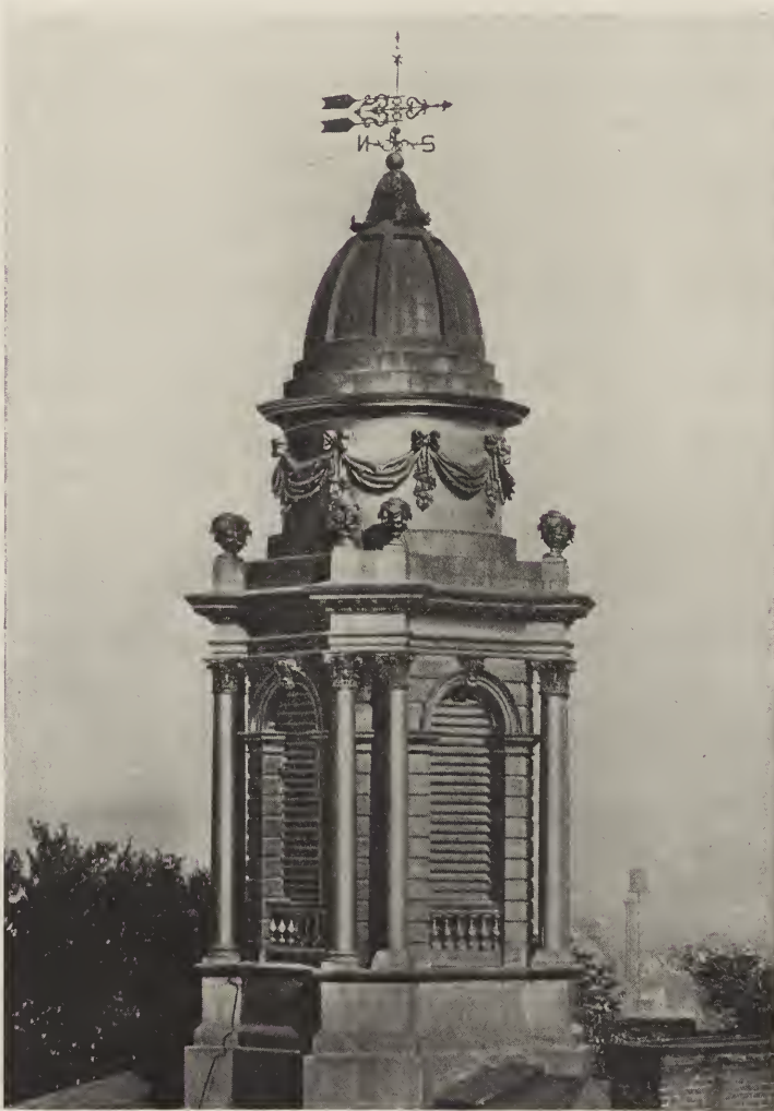
DETAIL OF TOWER—ALBANY (N. Y.) ACADEMY.
