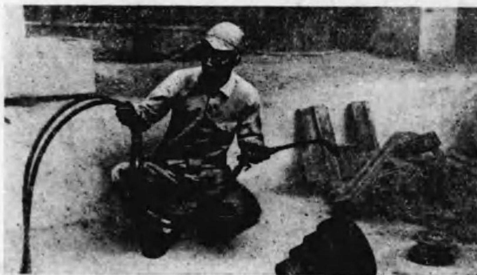
第111圖 安全なゴム管の引寄せ方
