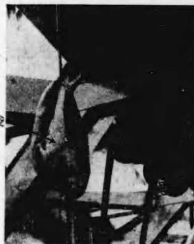
第75圖 工具を袋に入れて 高所の人に渡す
