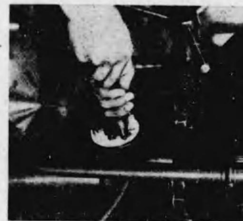
第131圖 開閉器修理中感電す
