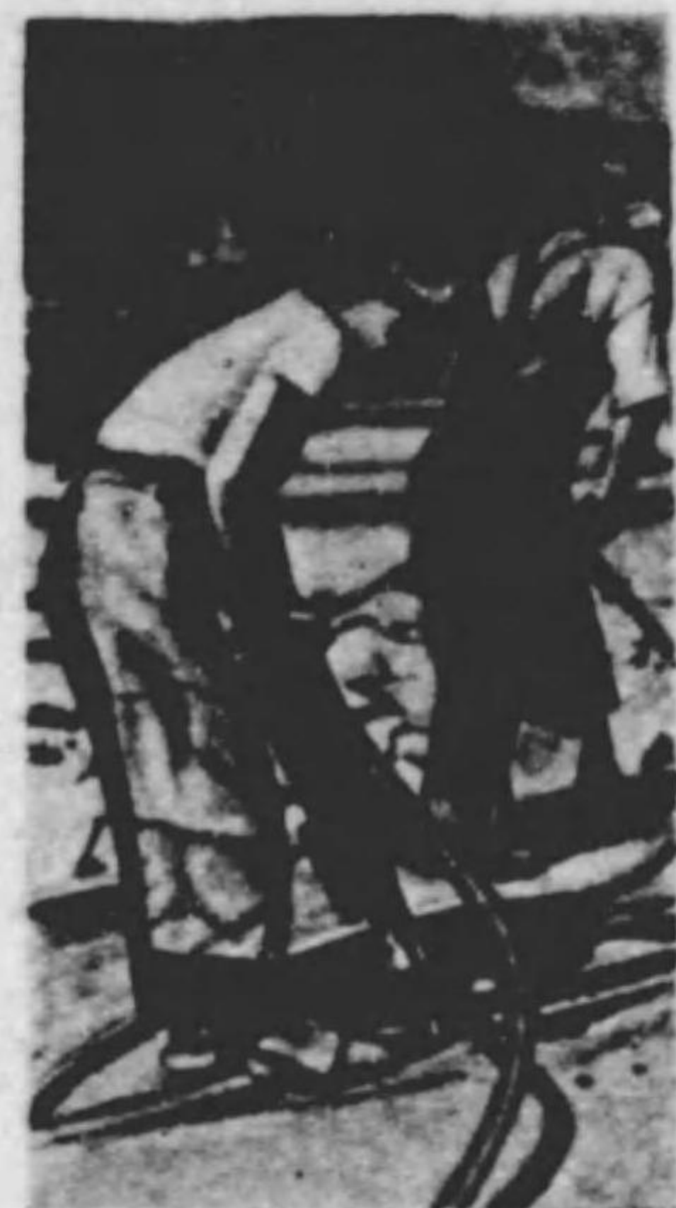
圖 20-2 壓搾空氣で働く、地面を掘る機械
