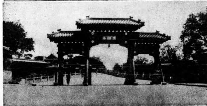
未 修 前 之 御 河 橋 牌 樓 →
