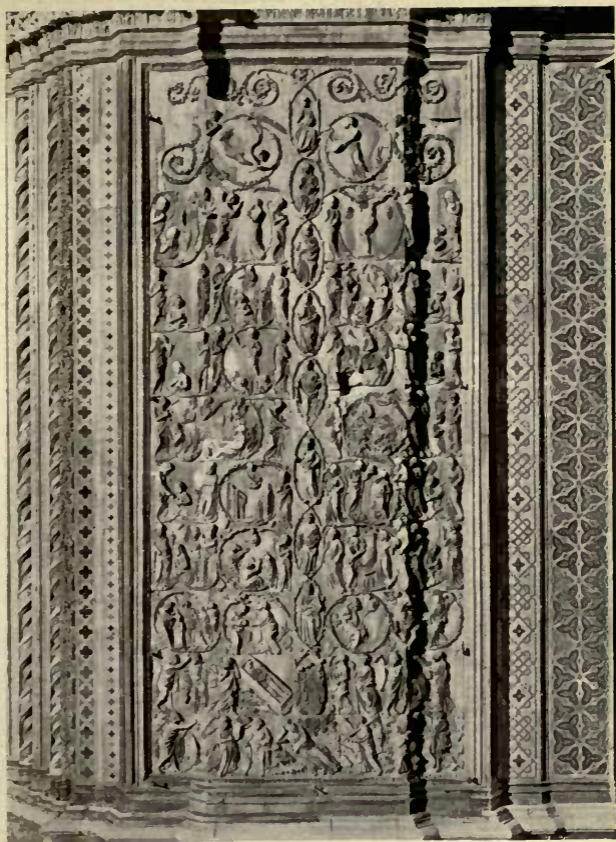
Secondo pilastro. Second pillar.
