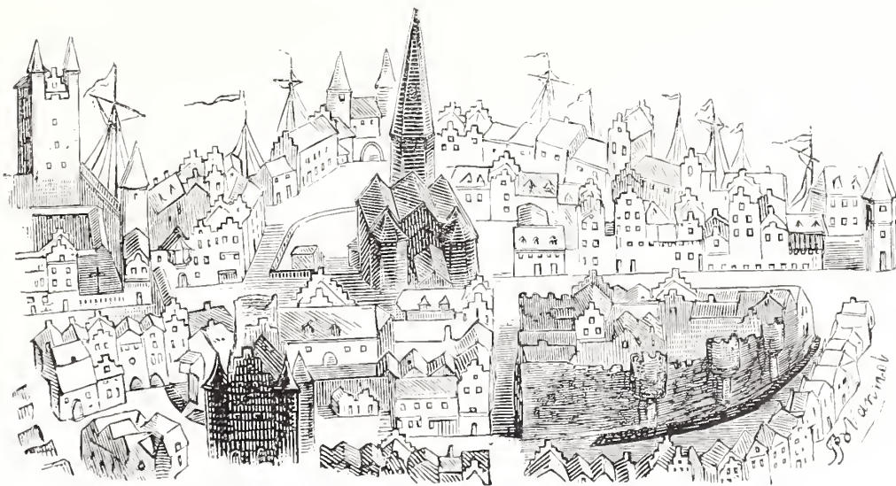
Vue intérieure du bourg.
