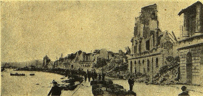
Рис. 4. Разрушенная землетрясеніемъ Мессинская набережная.
