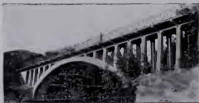
Ponte sul Rino per la Ferrovia Valbrembrana.
