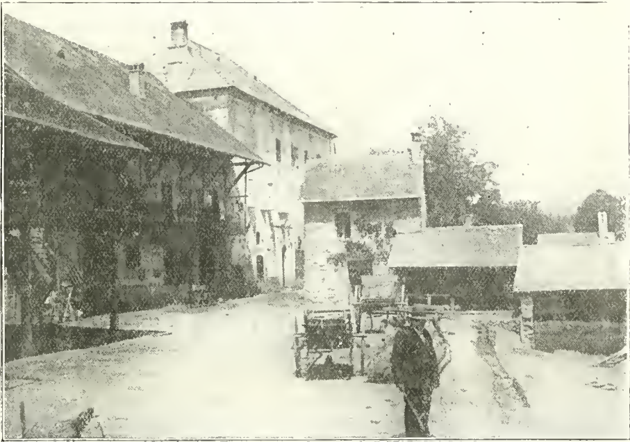
Fig. 41. — Bâtiments de la ferme de Charance.
