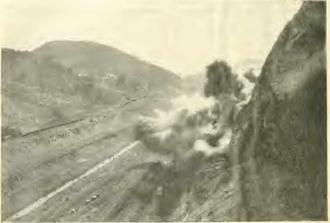
Fig. 131. — Explosion d'une mine de dynamite dans la tranchée de la Culebra.
