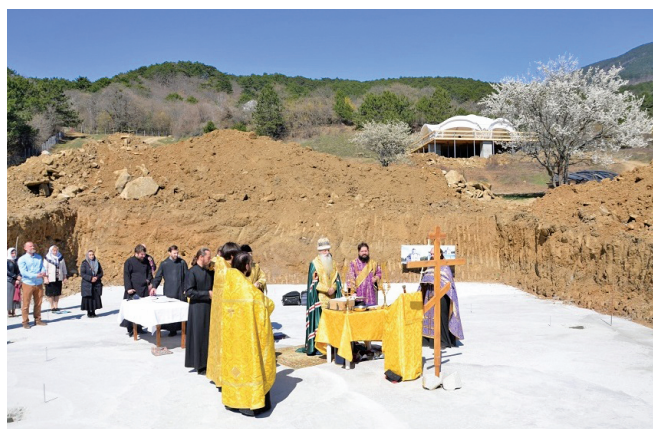
Освячення будівництва старообрядницького храму в Гурзуфі
