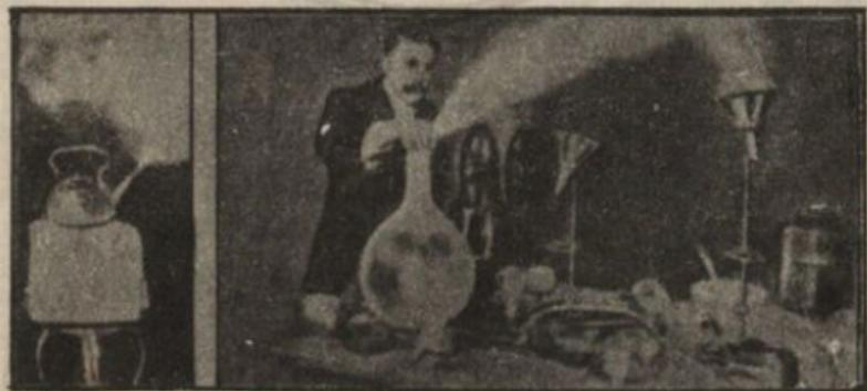
左圖是放在冰上的一壺液體空氣，樣子就像一壺濃水。冰比了那種液體空氣要暖得多，因此就將牠化成氣體，和平常空氣一樣。右圖是一杯液體空氣，傾入了一瓶水，牠就像水氣一般，嘶嘶的逃出來。
