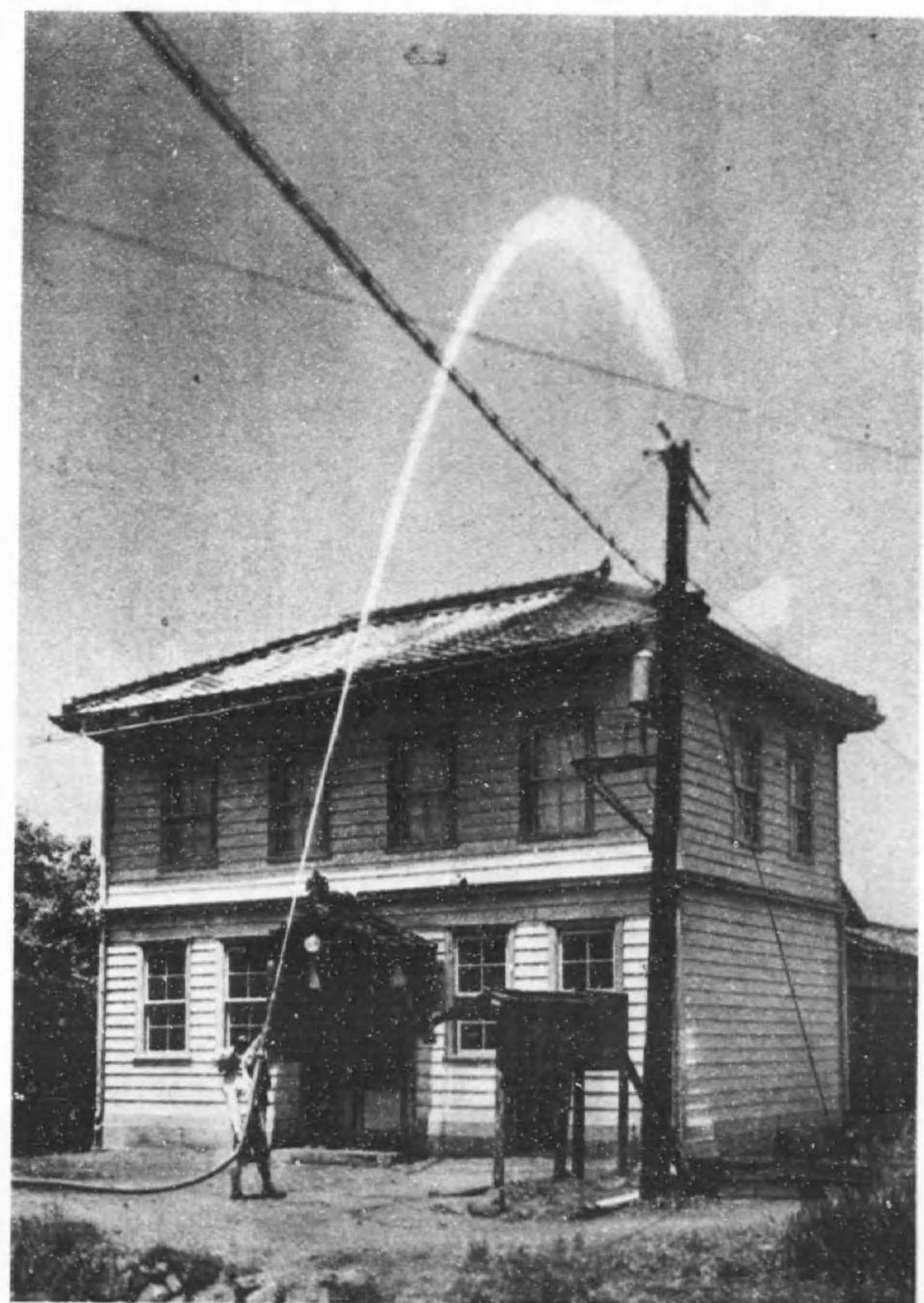
(新庄村役場前ニ於ケル消火栓直結放水ノ状況)
