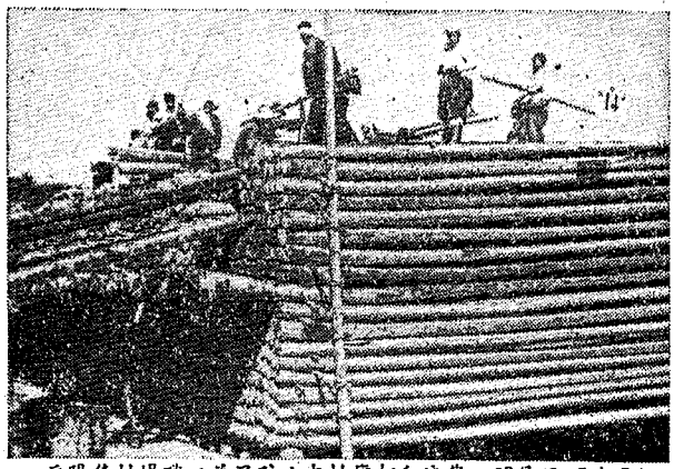
岳陽木材場職工為了防止木材腐爛和浪費，開展了「清場」工作，並把木材墊高，使木材能夠通風透氣，不致腐爛。
