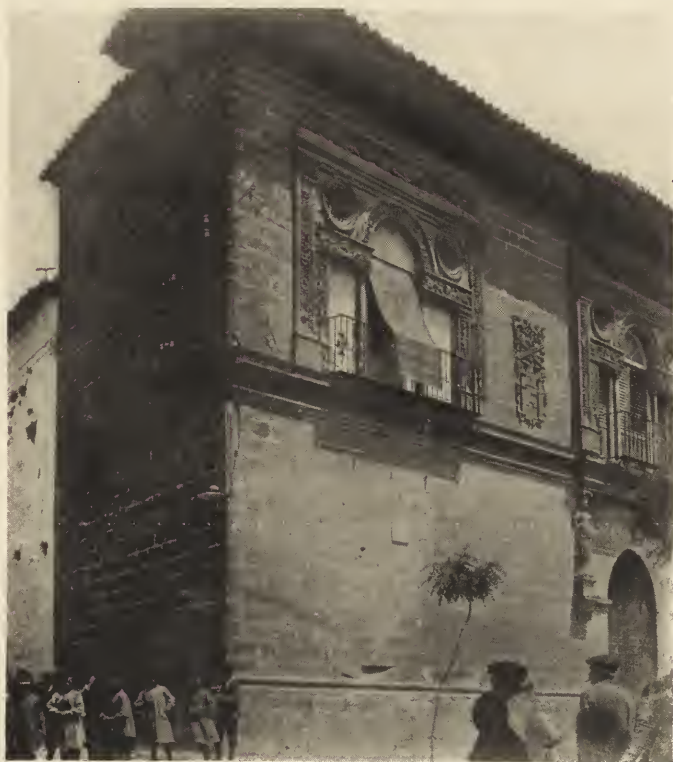
FIG. 106—Palladian Windows of the Ayuntamiento, Baeza.
