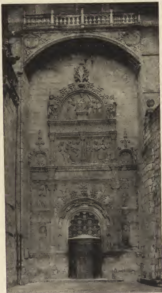
FIG. 26—Puerta de la Pellejería, Burgos Cathedral. Francisco de Colonia, Architect. 1516.
