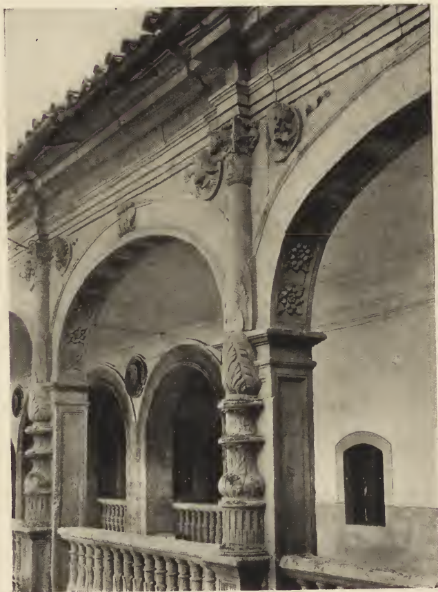
FIG. 50—Upper Cloister of the Colegio de los Irlandeses, Salamanca. Attributed to Pedro Ibarra.
