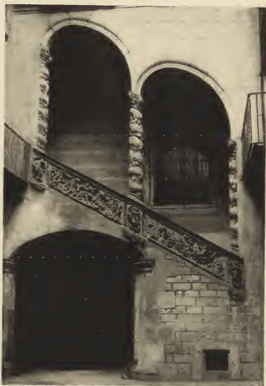
FIG. 118—Stairway in the Palacio de Moncado, Barcelona.
