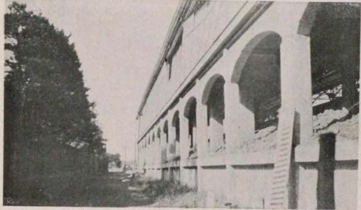
國有鐵道 山手線新築代々木驛乗降場鐵筋混凝土支柱の被害(其一)
