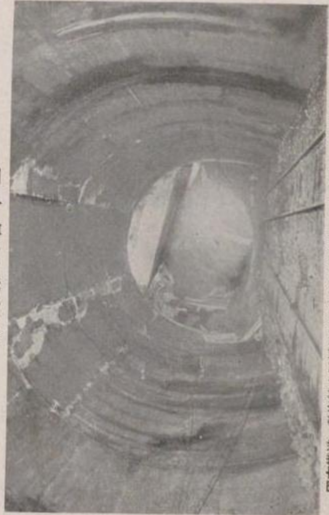
國有鐵道 熱海線小田原早川間小峰隧道(國府津起點 4哩 25 釐 80 節)國府津方坑門の破損
