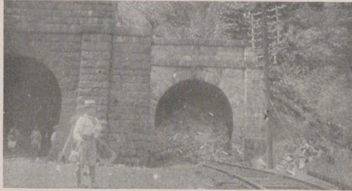
國有鐵道 東海道本線箱根第七號上り線隧道の崩壊土砂のため閉塞せられたる状況 (東京方坑門より望む)
