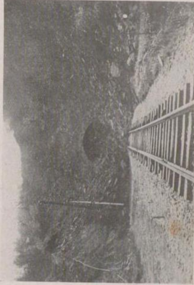
國有鐵道 熱海線早川根府川間下牧屋山隧道國府津方坑門の崩壁
