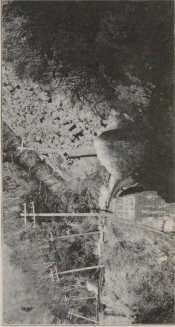
小田原電氣鐵道株式會社 箱根登山鐵道蛇骨川附近に於ける軌道の被害
