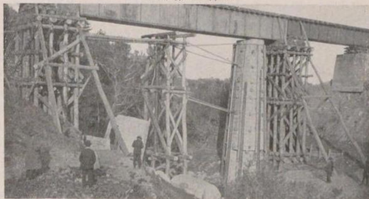
國有鐵道 北條線九重千倉間第一瀬戸川橋梁應急工事(線路右側より望む)
