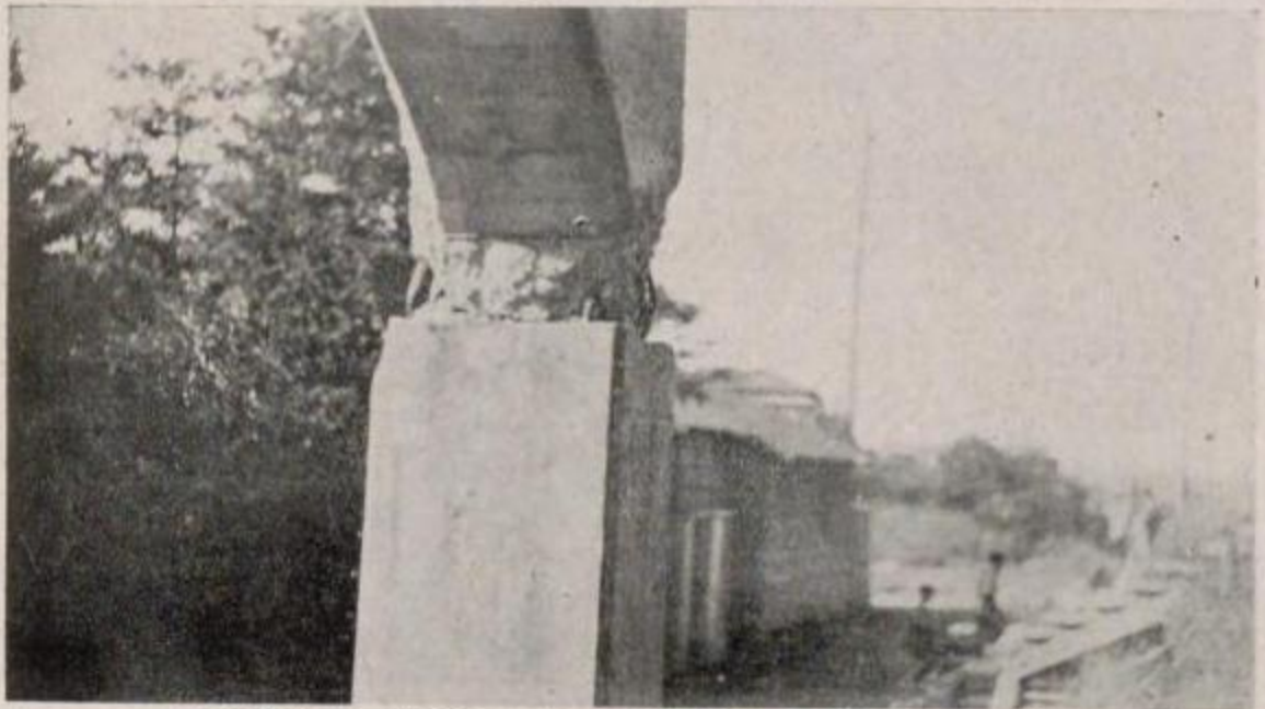
國有鐵道 山手線新築代々木驛乗降場鐵筋混凝土支柱の被害(其二)
