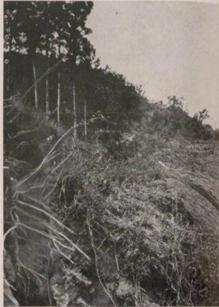
國有鐵道 北條線上總湊濱金谷間天神山隧道江見方坑門附近左側山上大龜裂
