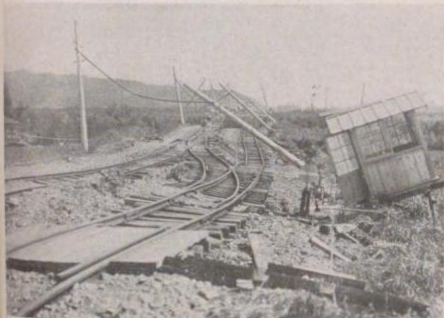
國有鐵道 熱海線國府津起點 1 哩 90 鎮附近築堤の沈下(起點に向て撮影)
