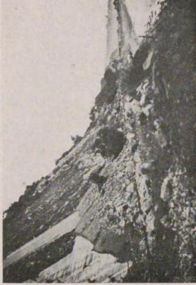
國有鐵道 熱海線早川根府川間國府津起點 5 哩 00 附近切取岩石崩落線路埋没
