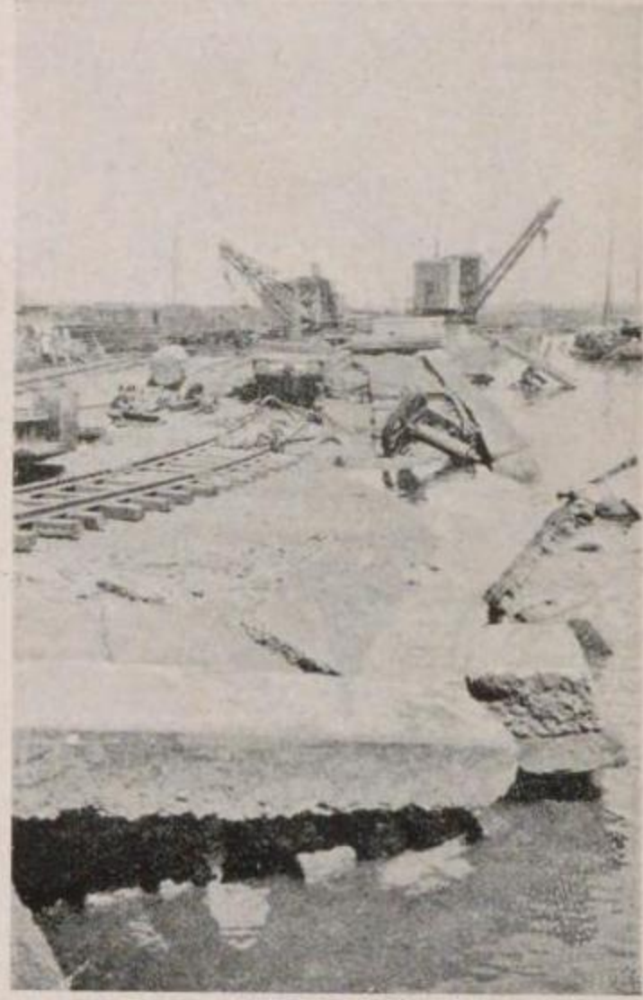
國有鐵道 東海道鶴見程ヶ谷間貨物支線横濱倉庫岸壁の一部沈下破壊 (南より北を望む)
