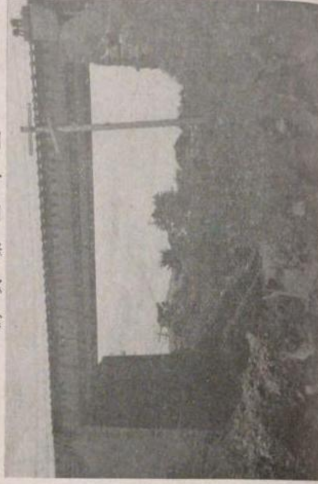
國有鐵道 東海道本線東京横濱間電車線跡見東神奈川間乗越線橋蓋裏の龜裂（東京方に向ひて撮影）
