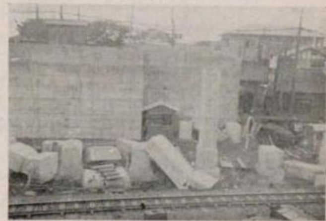
國有鐵道 山手線新宿驛構内に於ける新築中の驛舎を支ふる混凝土方柱の切斷顛倒(其一)
