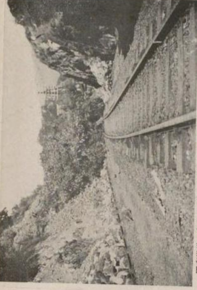
国有鐵道 東海道本線山北谷間箱根第三號及び第四號隧道間の山崩 び土留石取の崩壊
