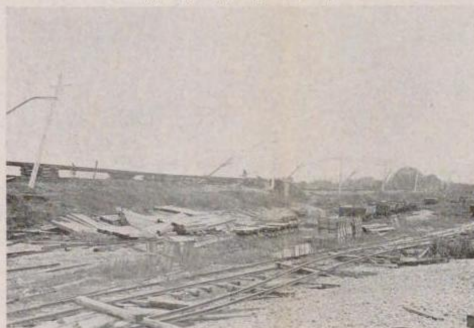
國有鐵道 熱海線國府津起點 2 哩 20 鎮附近築堤の沈下及び酒匂川砂利線構内の一部
