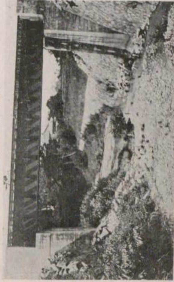
國有鐵道 北條線安房勝山岩井間台磯川橋梁橋脚及び翼壁の崩害 (線路左側より望む)
