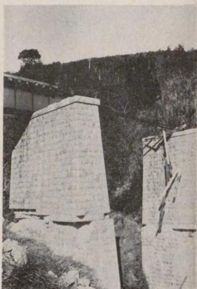
國有鐵道 熱海線根府川眞鶴間國府津起點 8 哩 70 鎖 45 節双龍ノ瀧橋梁の被害
