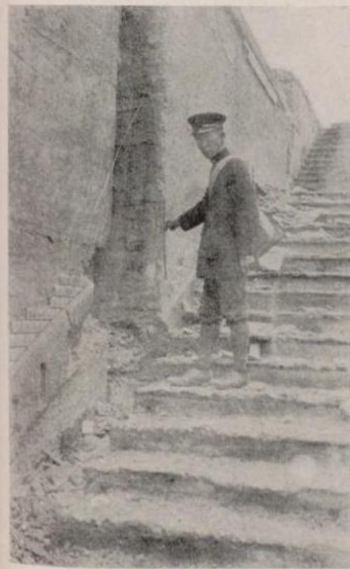
國有鐵道 東海道横濱櫻木町間電車線櫻木町驛地下道の破壊（其二）
