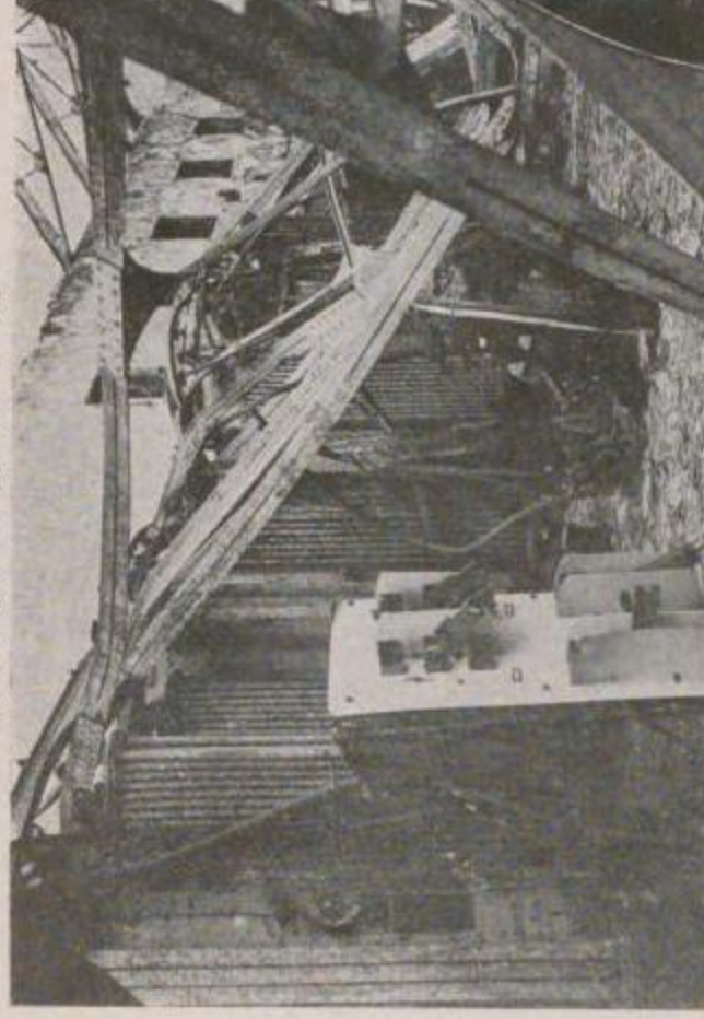
國有鐵道 焼失せる永樂町變電所の變壓器
