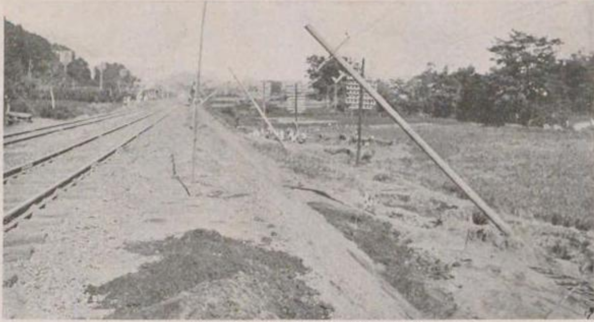
國有鐵道 二宮驛附近配電線路の被害
