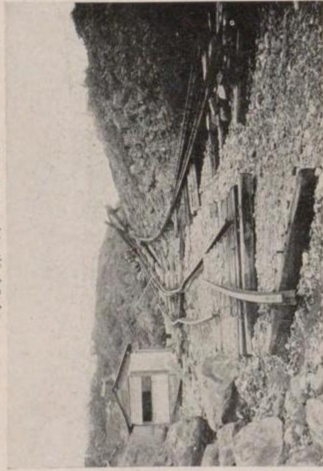
國有鐵道 熱海線根府川驛構内 (國府津起點 7 哩 52 鎮 00 節) 彎曲せ る軌條 (其一)
