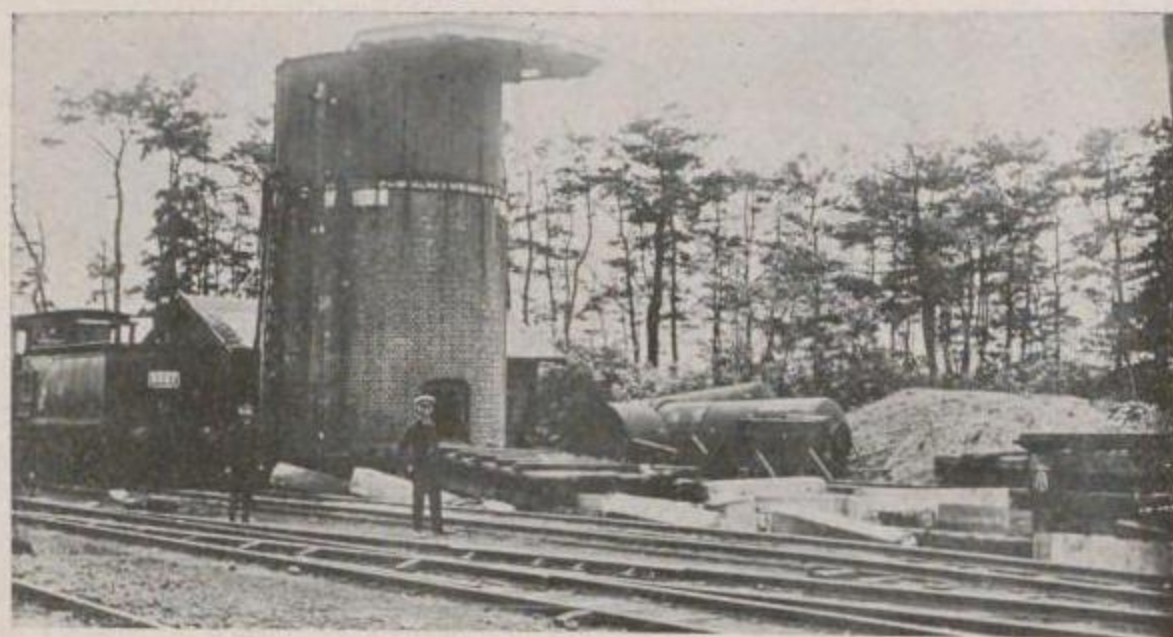
國有鐵道 北條線安房北條驛給水槽蓋の移動(千葉方より望む)
