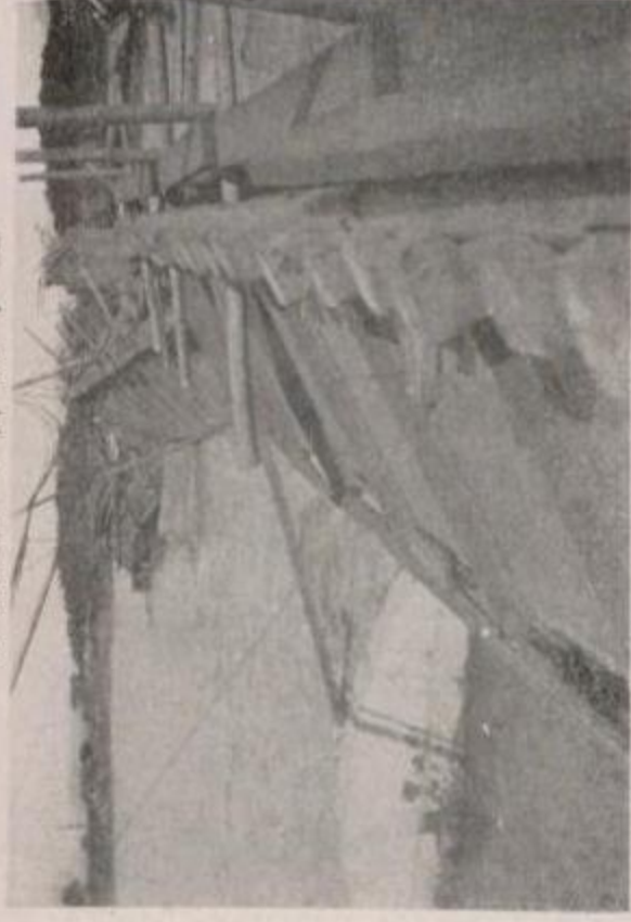
國有鐵道 東海道本線茅ヶ崎平塚間馬入川橋梁上り橋第十三號 橋脚の倒壊(沼津方を望む)
