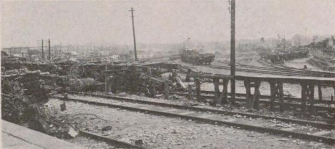
國有鐵道 飯田町驛構内配電線路の燒失
