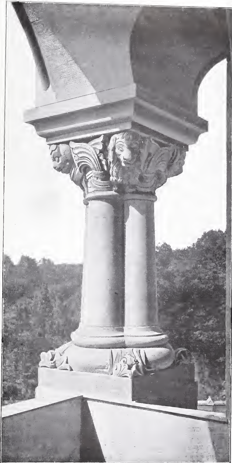
Neues Romanisches Haus. Pfeiler vom Erker des Turmes. Architekt: FRANZ SCHWECHTEN in Berlin.
