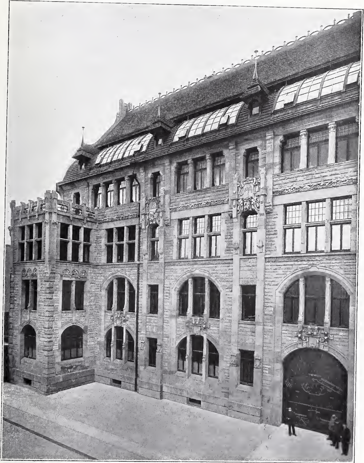
Rathaus für Charlottenburg. Fassade nach der Lützowerstrasse. Architekten: REINHARDT & SÜSSENGUTH in Charlottenburg.
