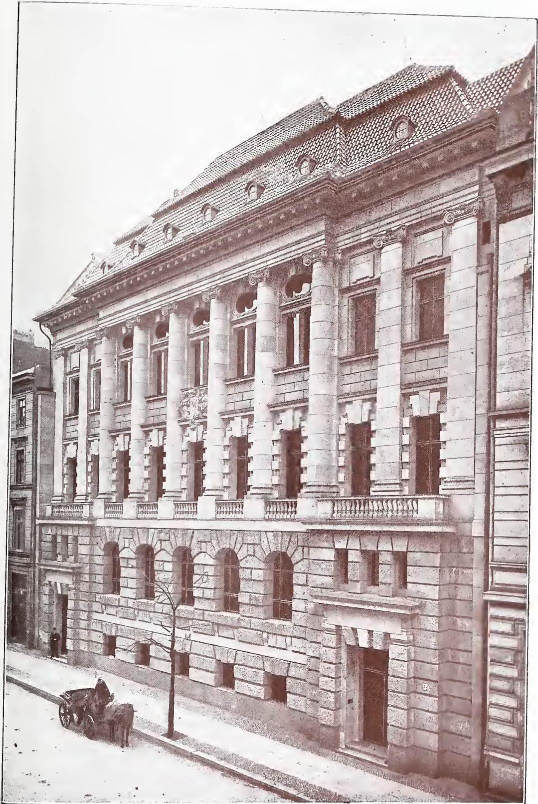
Neubau der Berliner Handelsgesellschaft. Architekt: ALFRED MESSEL in Berlin.
