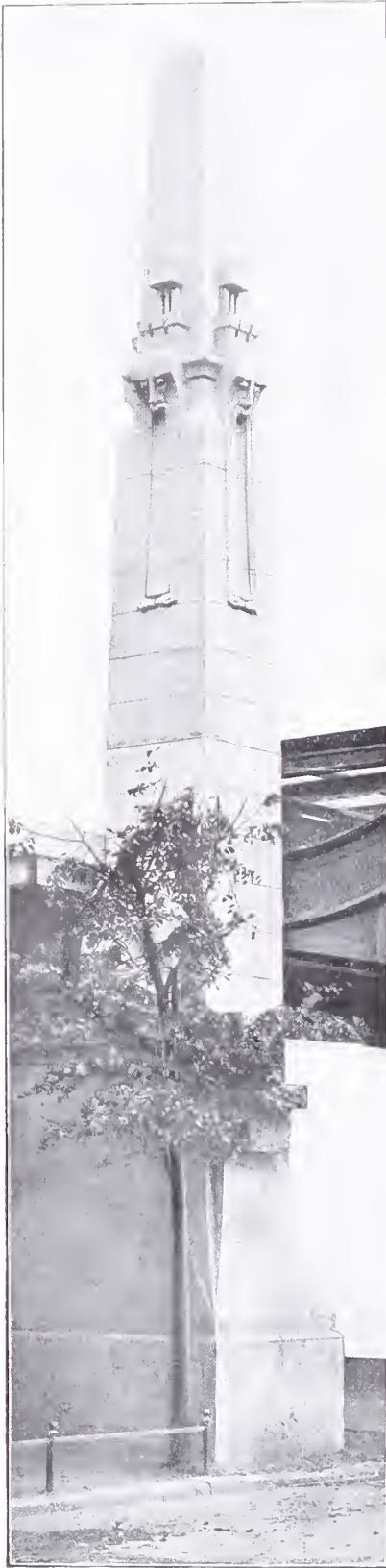
Pfeiler der Hochbahn.
