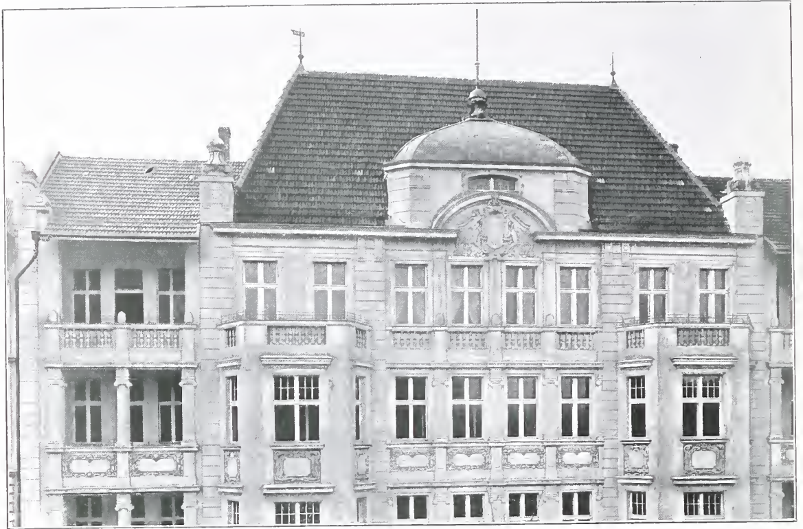
Fassadendetail des Wohnhauses Wilmsdorferstrasse 39 in Charlottenburg. Architekt: AGATHON REIMANN in Berlin.
