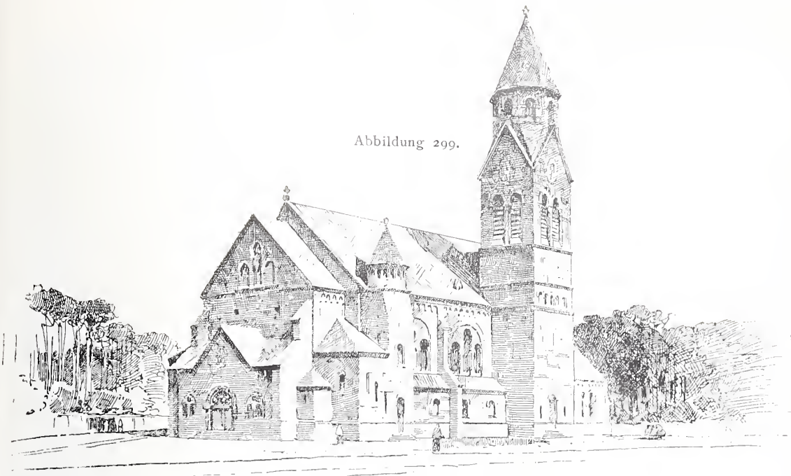
Wettbewerb für eine evangelische Kirche in Grunwald. Architekt: JOH. KRAAZ in Berlin. 1. Preis.
