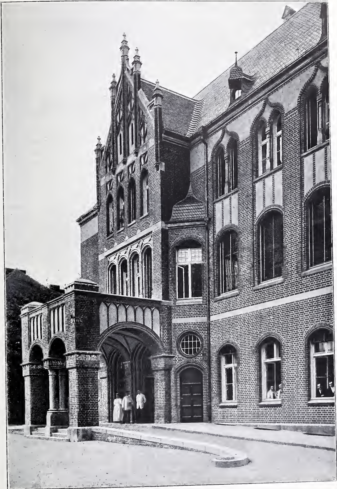
Direktorialgebäude der Kgl. Charité, Portal und Giebel in der Charitéstrasse. Architekt: G. DIESTEL in Berlin.
