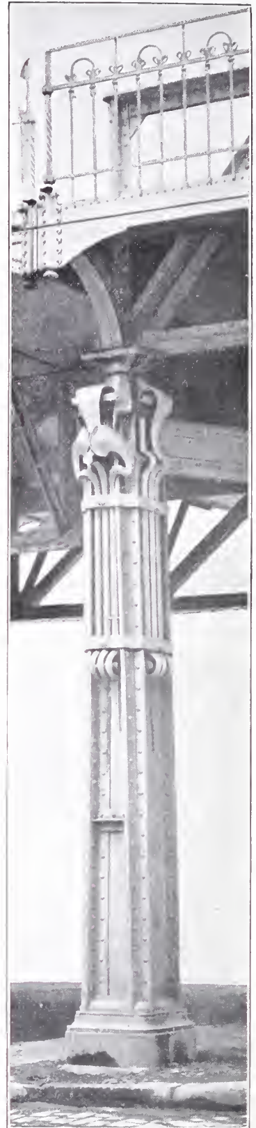
Hochbahnpfiler und Geländer. Architekt: ALFRED GRENANDER in Berlin.
