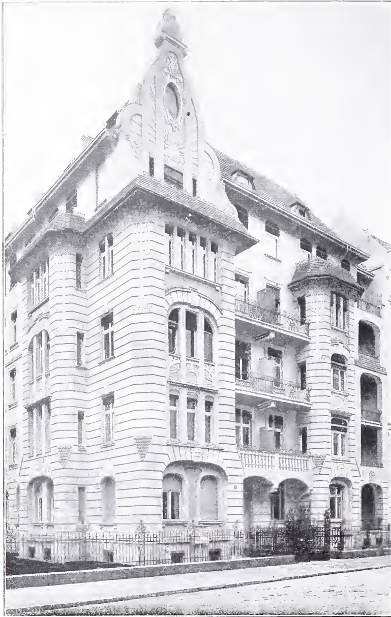
Wohnhaus Luitpoldstrasse 31. Architekt: PAUL JATZOW in Berlin.
