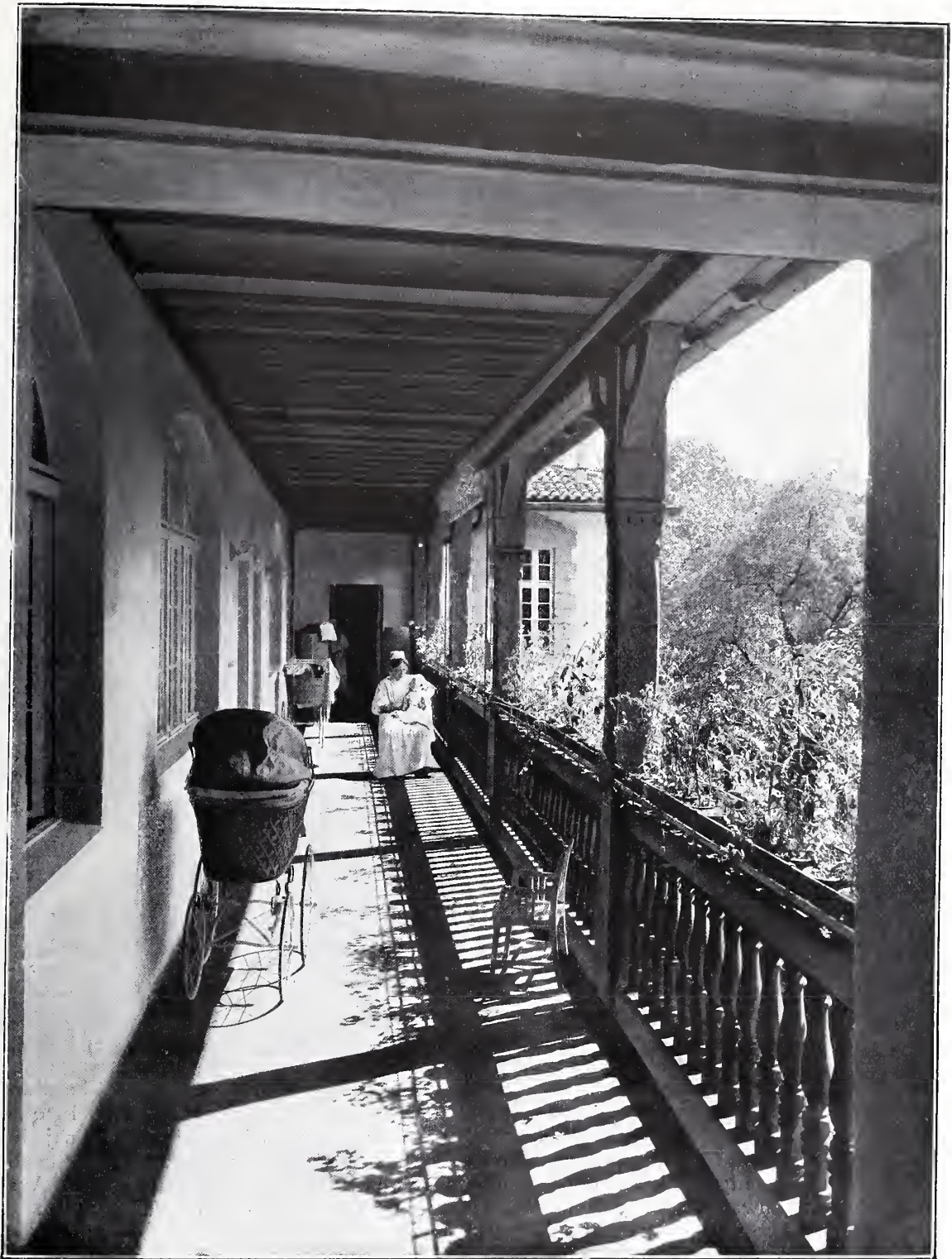
Kinderasyl in der Kürassierstrasse 20-21. Veranda am Waldeck-Park. Architekt: LUDWIG HOFFMANN in Berlin.
