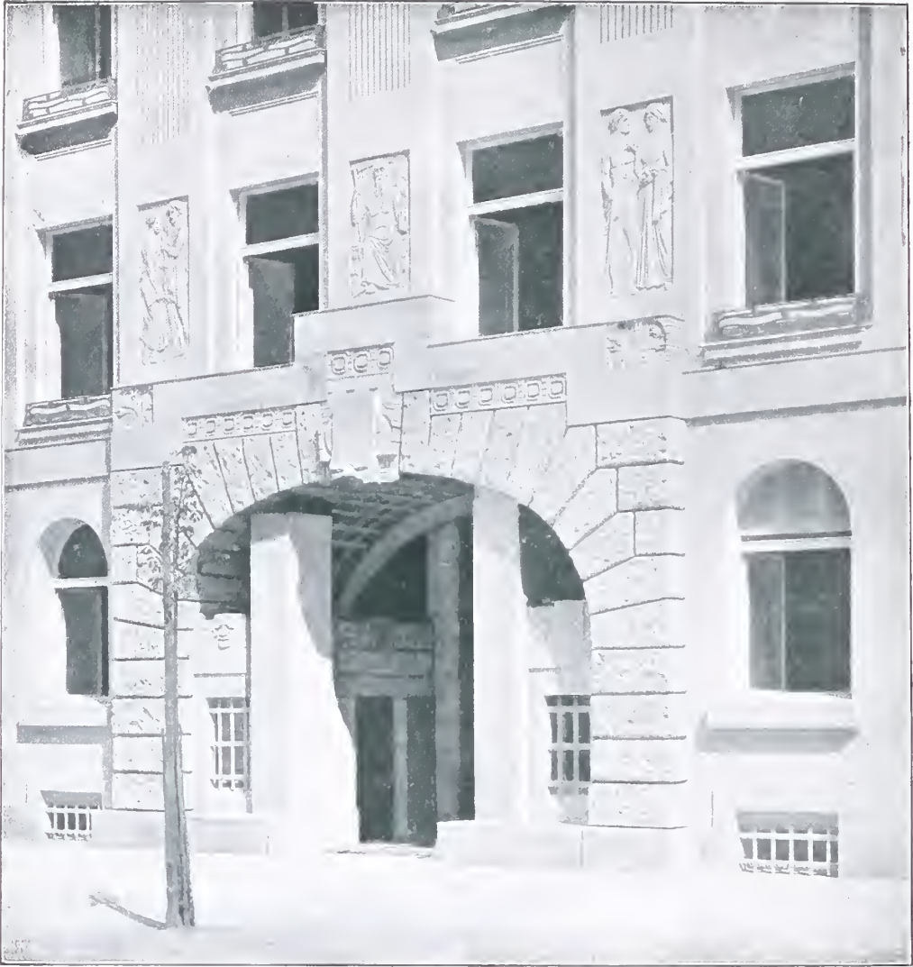
Portal am Wohnhaus Meineckestrasse 23. Architekt: PAUL HOPPE in Berlin.
