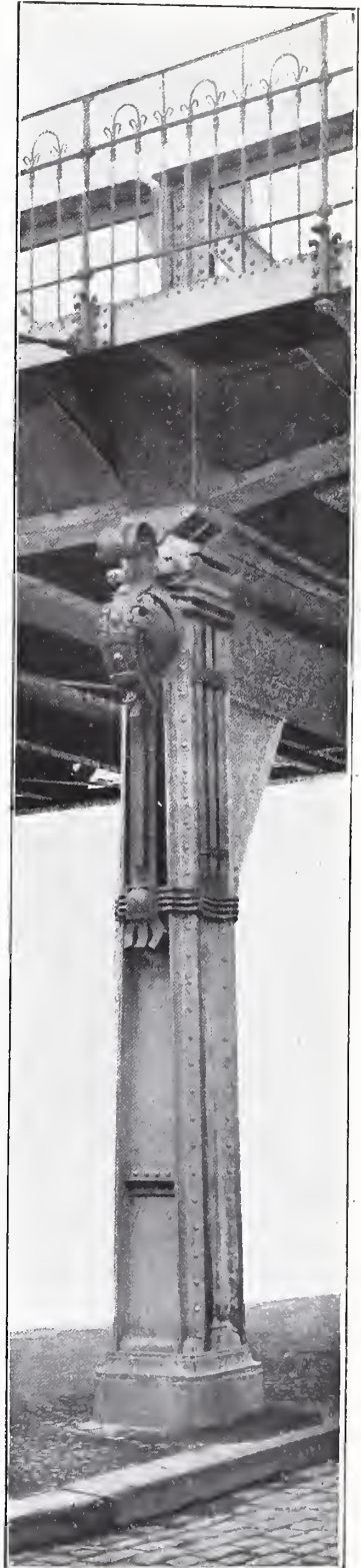
Hochbahnpfiler und Geländer. Architekt: ALFRED GRENANDER in Berlin.
