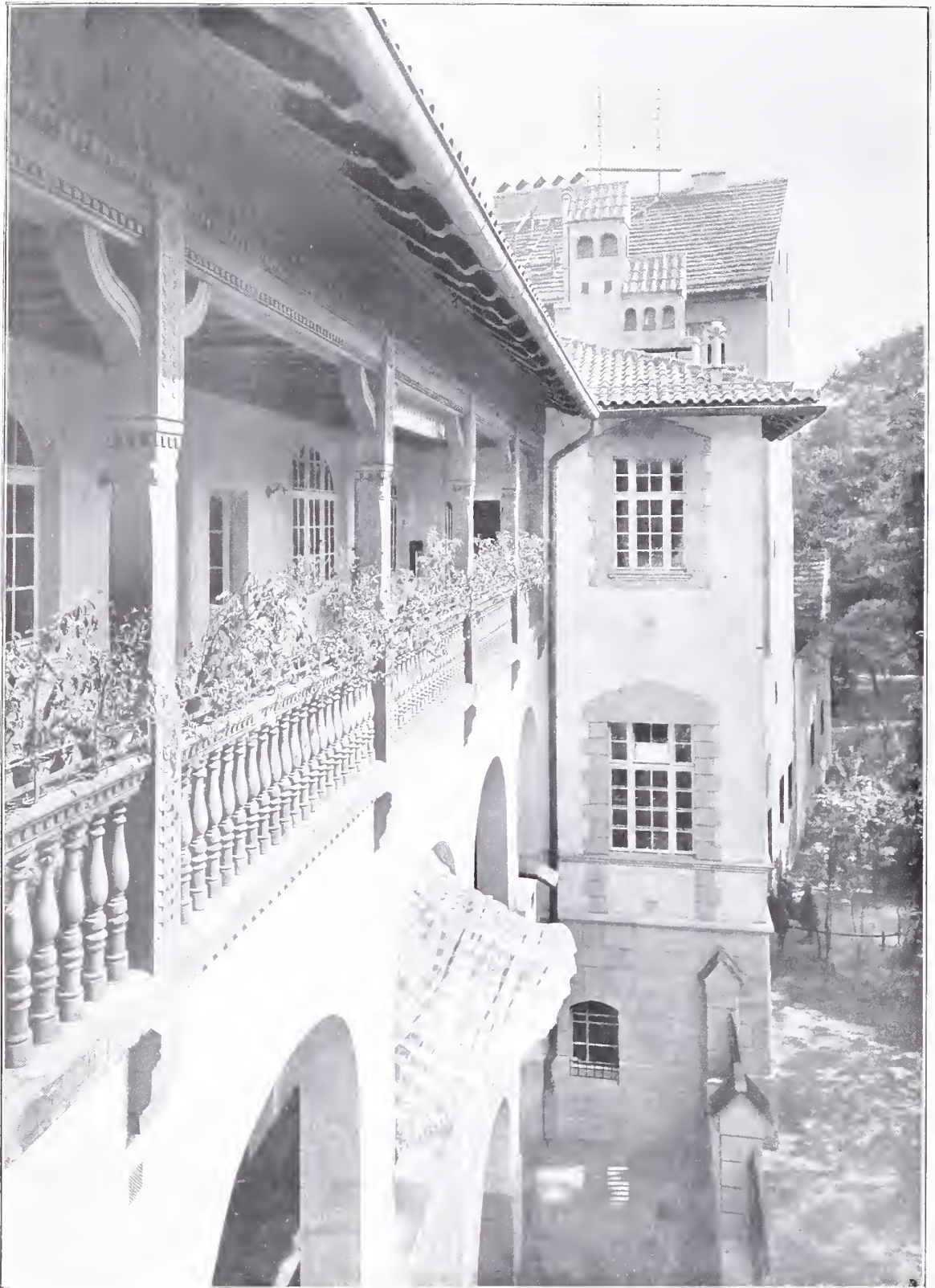
Kinderasyl in der Kürassierstrasse 20-21. Aeusseres der Veranda am Waldeck-Park. Architekt: LUDWIG HOFFMANN in Berlin.
