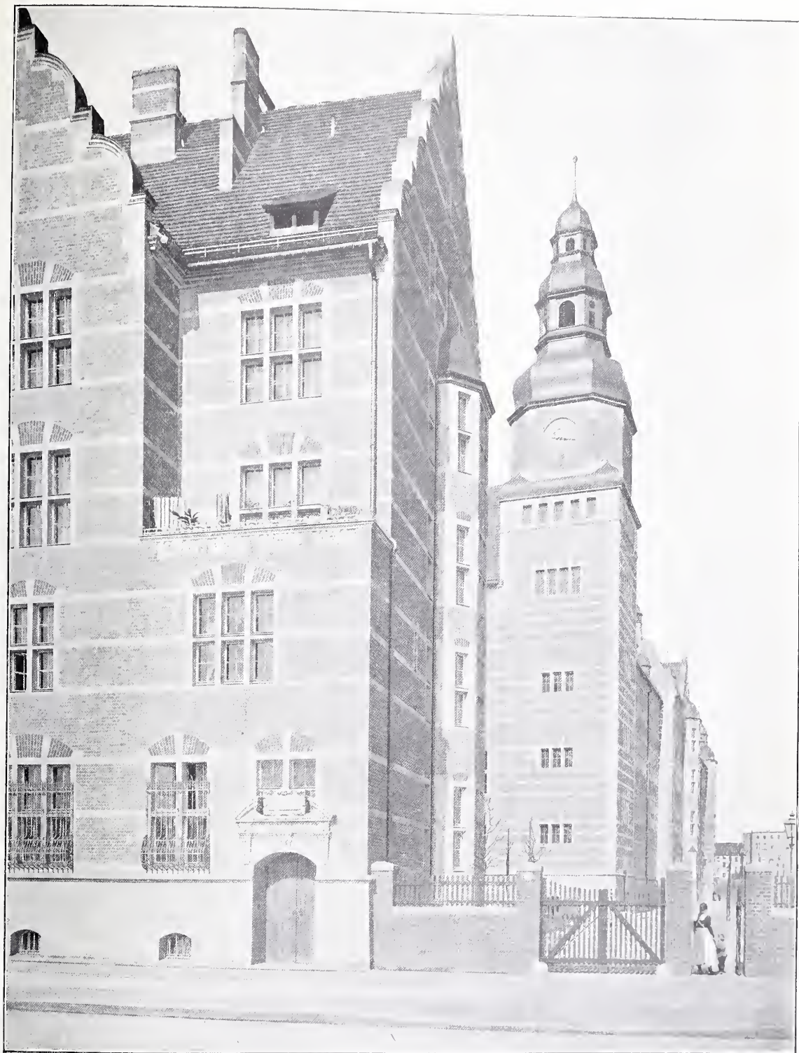
Gemeindedoppelschule in der Dunckerstrasse. Lehrerwohnhaus und Schule. Architekt: LUDWIG HOFFMANN in Berlin.
