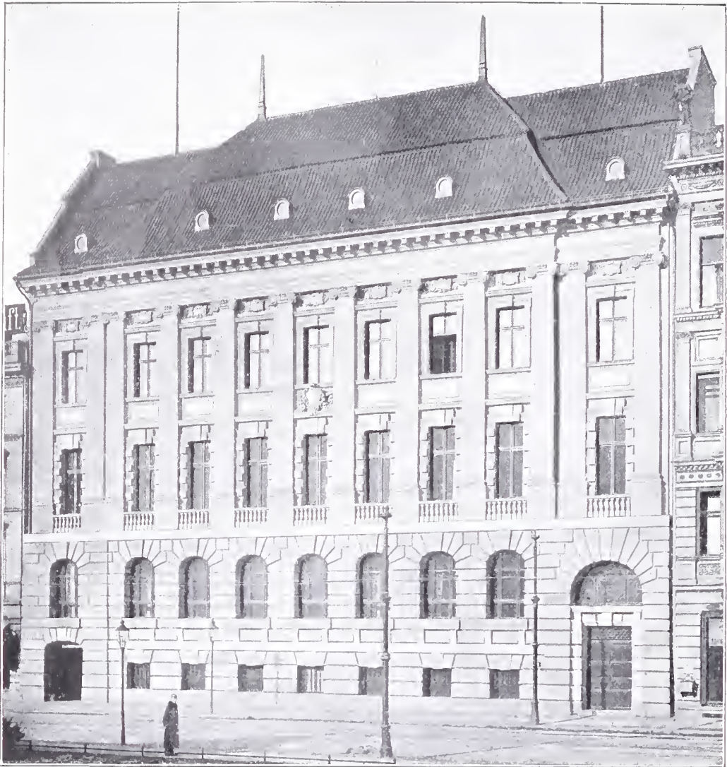
Neubau der Berliner Handelsgesellschaft. Architekt: ALFRED MESSEL in Berlin.
