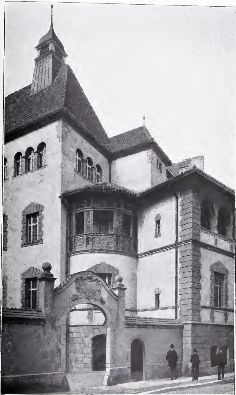
Kinderasyl in der Kürassierstrasse 20 u. 21. Rechter Eckbau. Architekt: LUDWIG HOFFMANN in Berlin.
