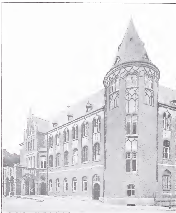
Direktorialgebäude der Kgl. Charité, Charitéstrasse Ecke Schumannstrasse. Architekt: G. DIESTEL in Berlin.
