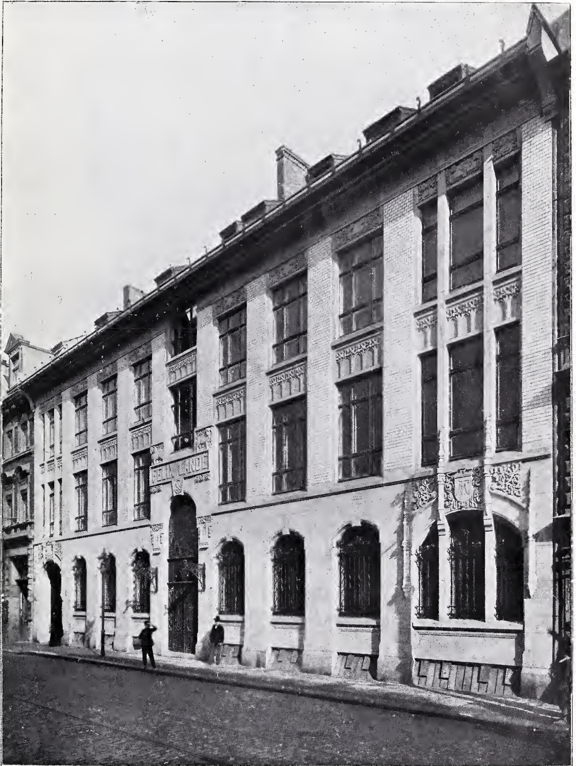
Geschäftshaus Felix-Lande, Markusstrasse 12. Architekt: GEORG LEWY in Charlottenburg.
