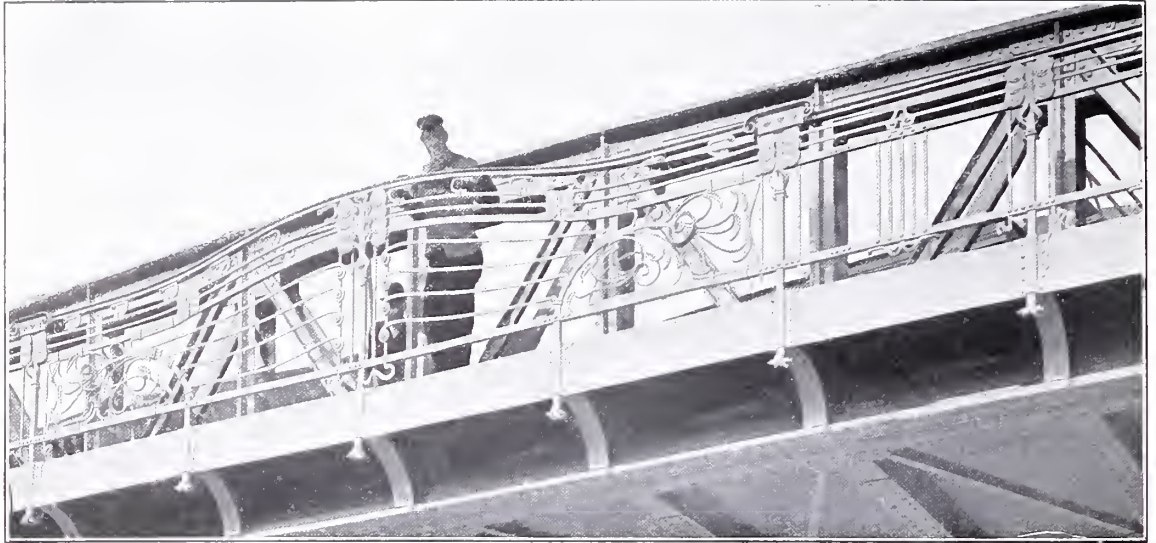
Geländer an der Hochbahn in der Gitschinerstrasse. Architekt: ALFRED GRENANDER in Berlin.
