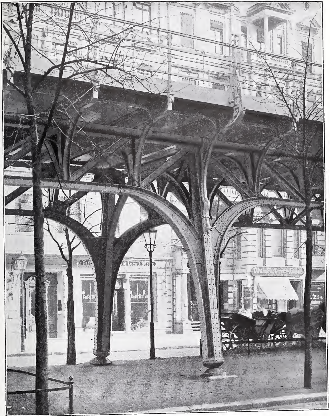
Hochbahn Pfeiler und Geländer zwischen Potsdamer- und Frobenstrasse. Architekt: ALFRED GRENANDER in Berlin.
