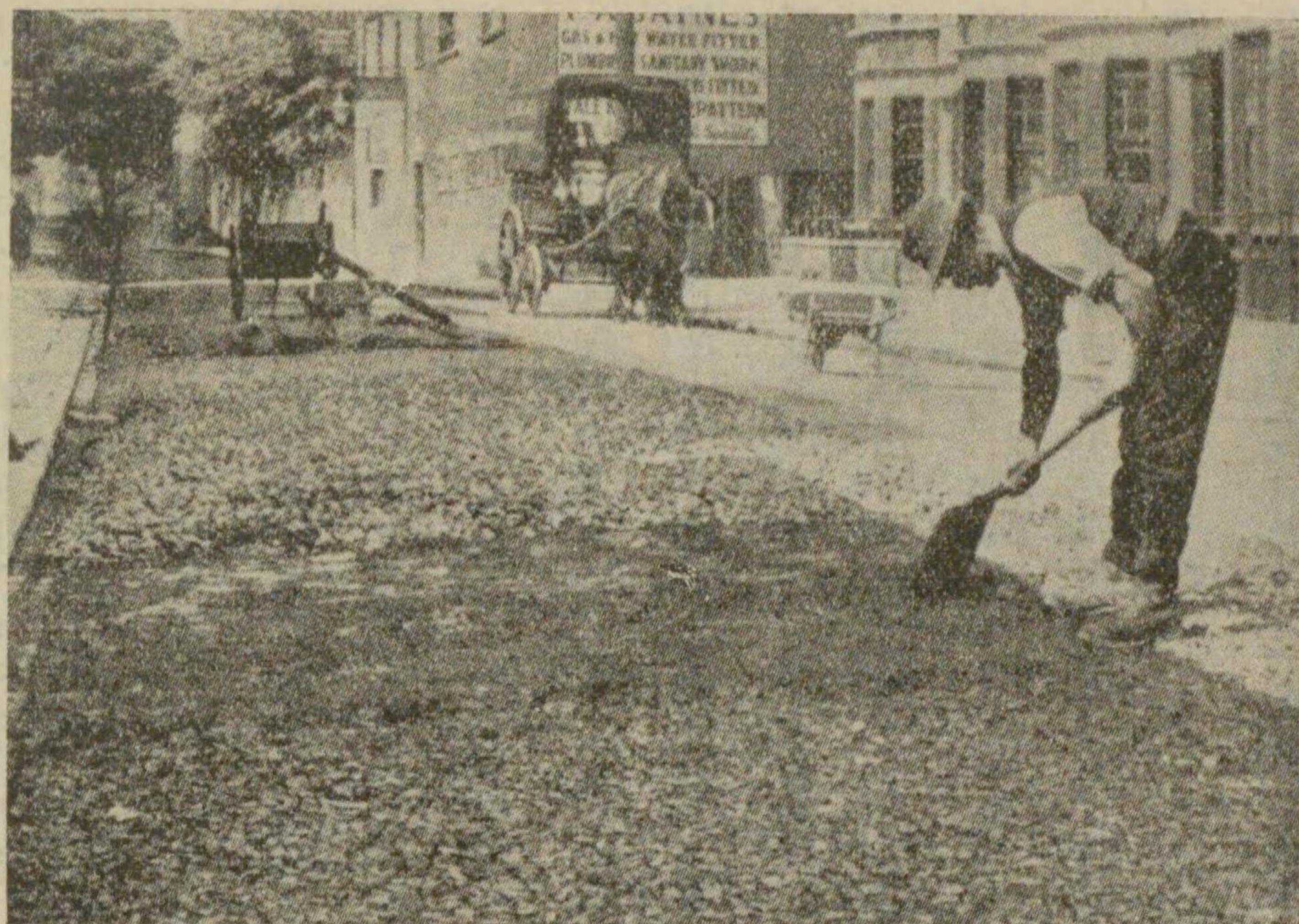
第一圖 セメント締道路構造、前方は底層及接合材を擴げた所、後方は頂層を擴げたる所
