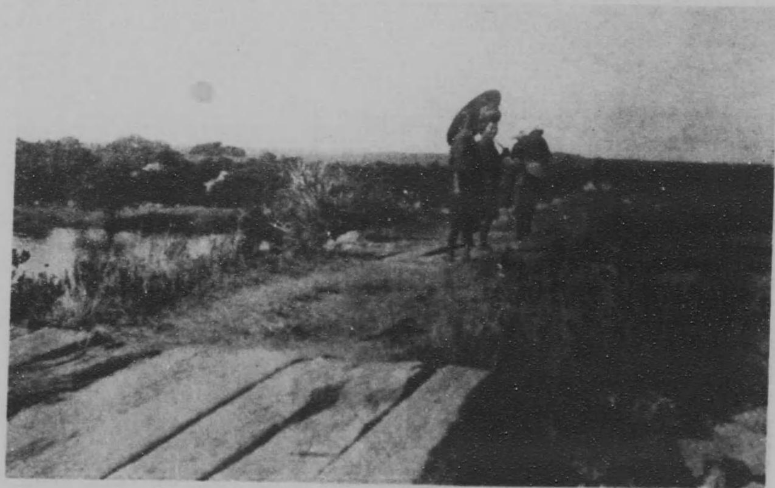
宮良川橋上よりのとも岳を望む
