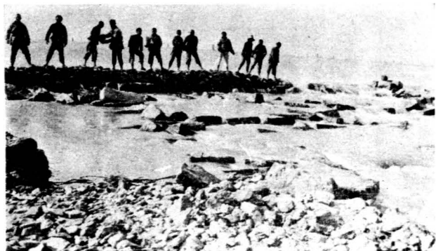
撫廟西堤南口堆築石埧
