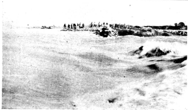
擴廟西堤南口捆石堵築工作情形 →
