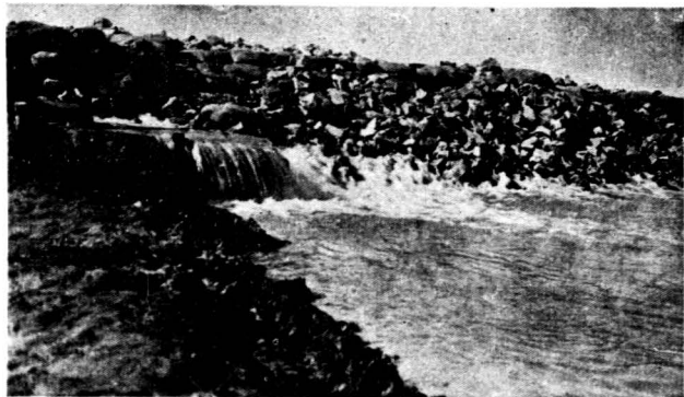
(十一月五日攝時將合龍) 撫廟西堤南段較小缺口之堵塞
