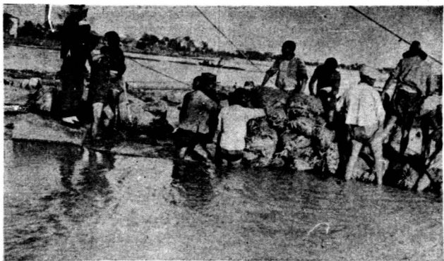
擴廟西堤南口捆石堵築工作情形 →
