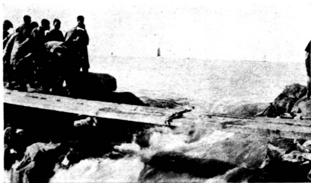
(十一月五日攝時將合龍) 撫廟西堤南段較小缺口之堵塞
