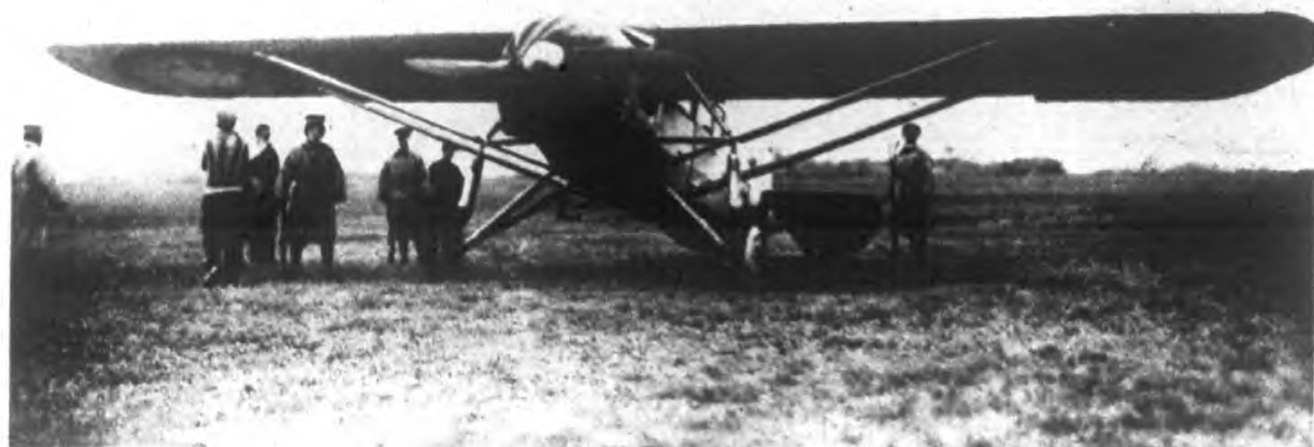
廣 州 號 飛 機 由 津 至 滬 後 飛 機 停 留 虹 橋 飛 機 場
