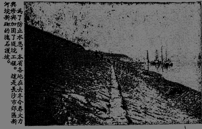
河與堤防新築的堤石護坡。本報各地記者在去冬今春大力
