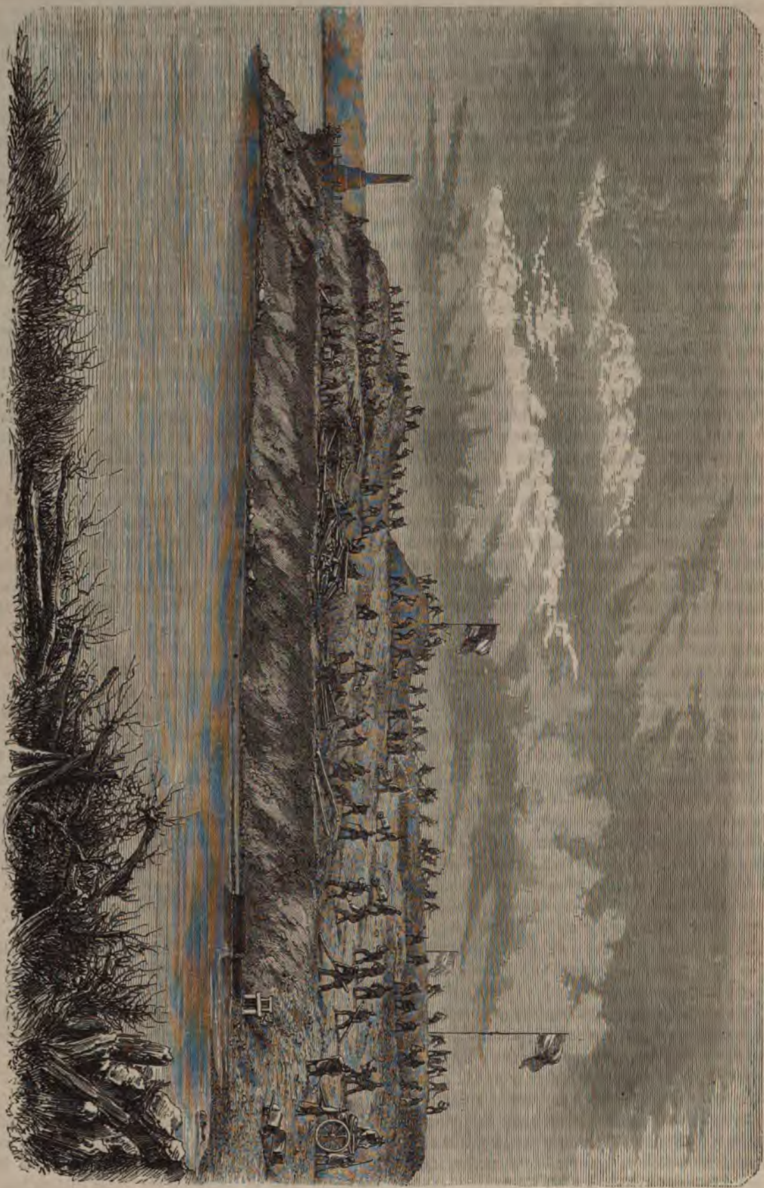
Demolition der Schanze von Danneville. (S. 31.)
