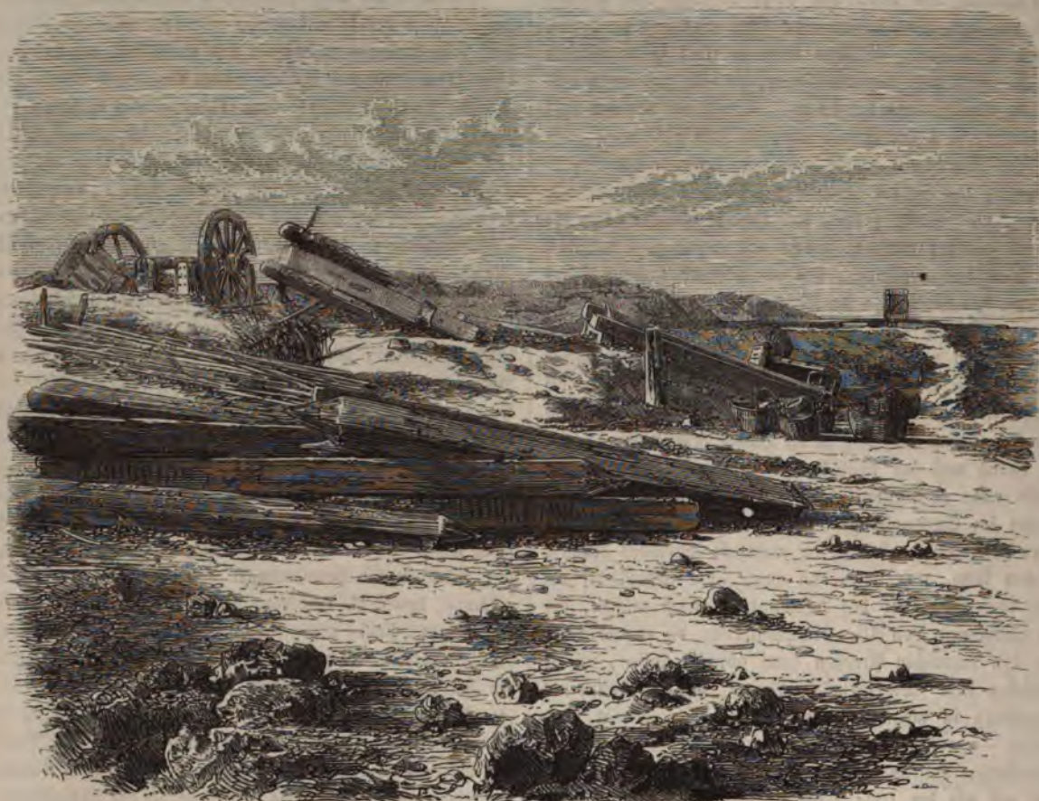
Düppelschanze Nr. 6 nach dem Sturm. Nach einer Photographie von F. Brandt. (S. 111.)
