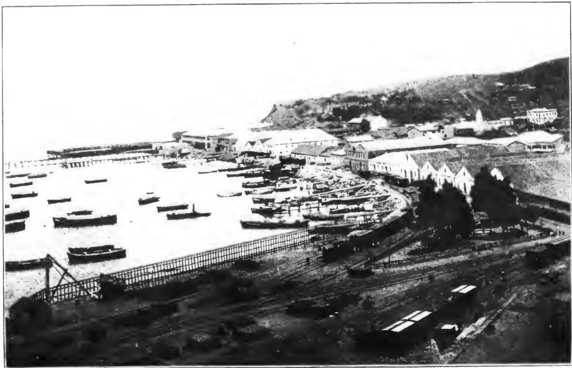
MUELLE DEL PUERTO DE TALCAHUANO, CHILE.
