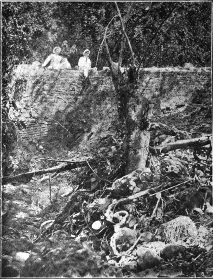
Dique de mampostería construido por J. RIZAL y sus discípulos para conducir el agua de una cascada á su casa de Talisay (Dapitan, Mindanao).—Véase la pág. 318. — De fotografía tomada el 4 de Marzo de 1906, y remitida por D. Felipe G. Calderón.
