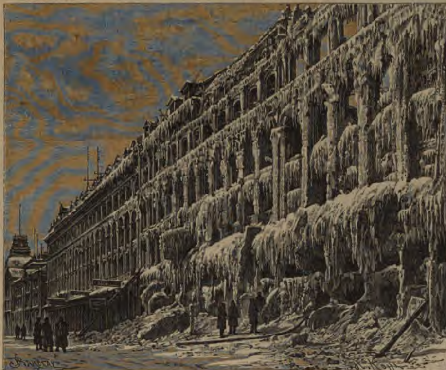
Ледяные сталактиты на фасадѣ горѣвшаго дома, въ Монреалѣ.
