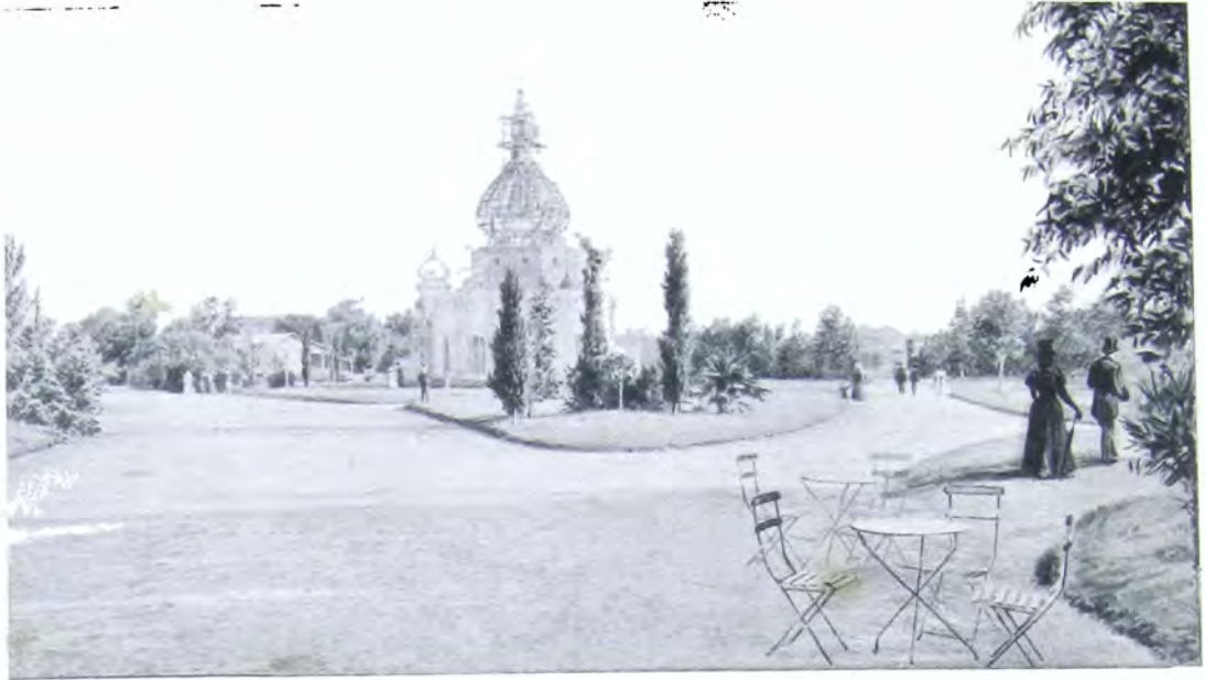
DEPARTAMENTO DE LOS LOROS (EN CONSTRUCCIÓN)
