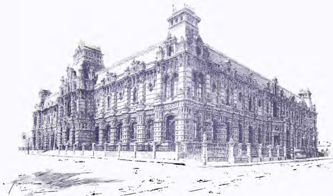
DEPÓSITO DE AGUAS CORRIENTES — BUENOS AIRES
