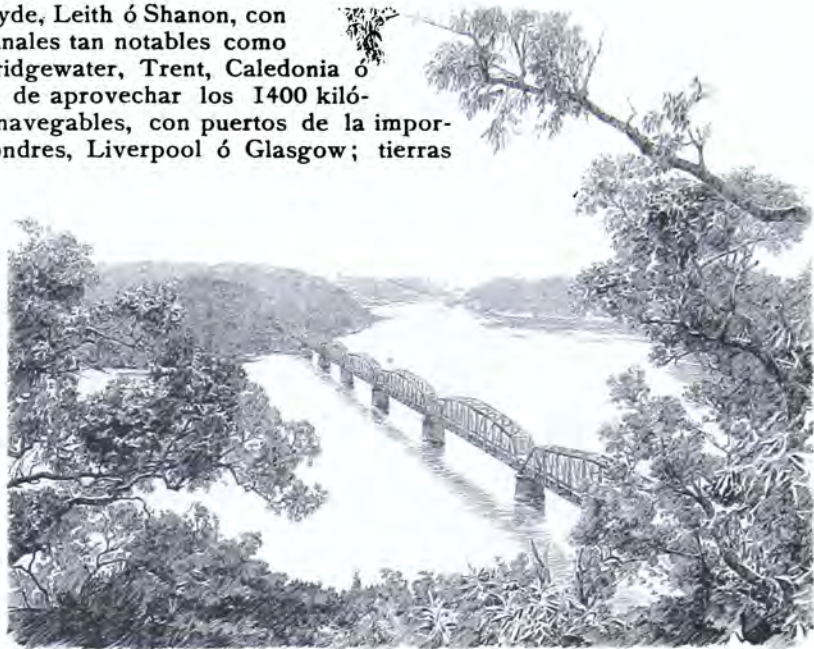
PUENTE DEL RÍO HAWKESBURY EN AUSTRALIA
