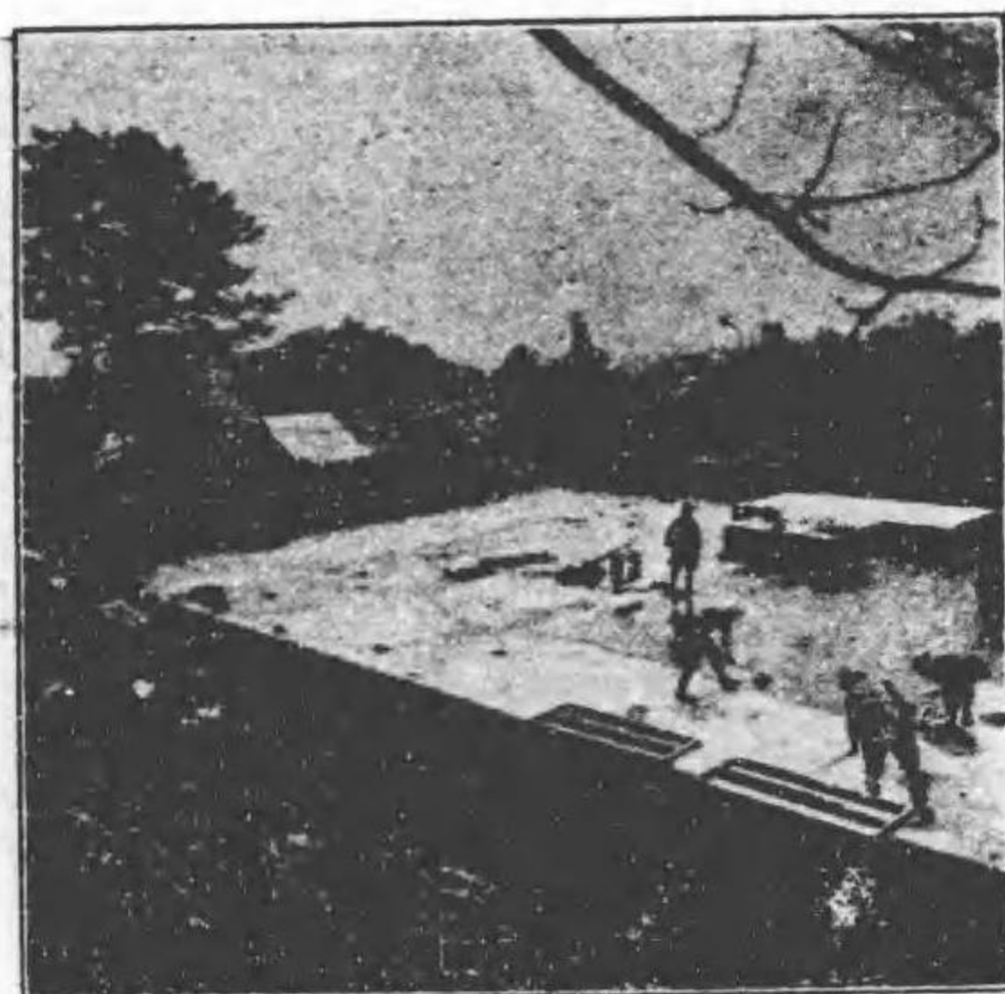
配水池蓋部アスファルト
