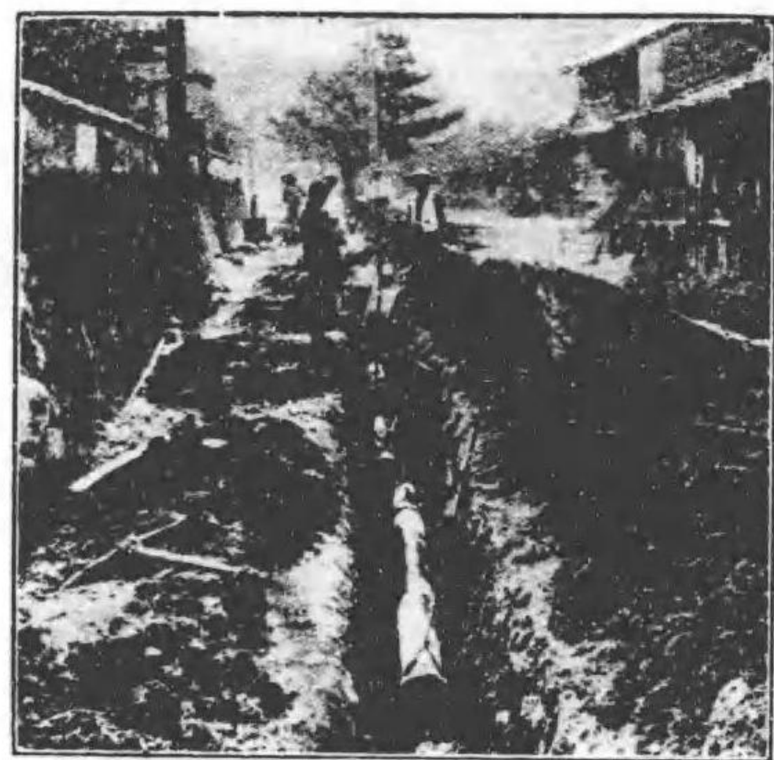
市内配水管布設
