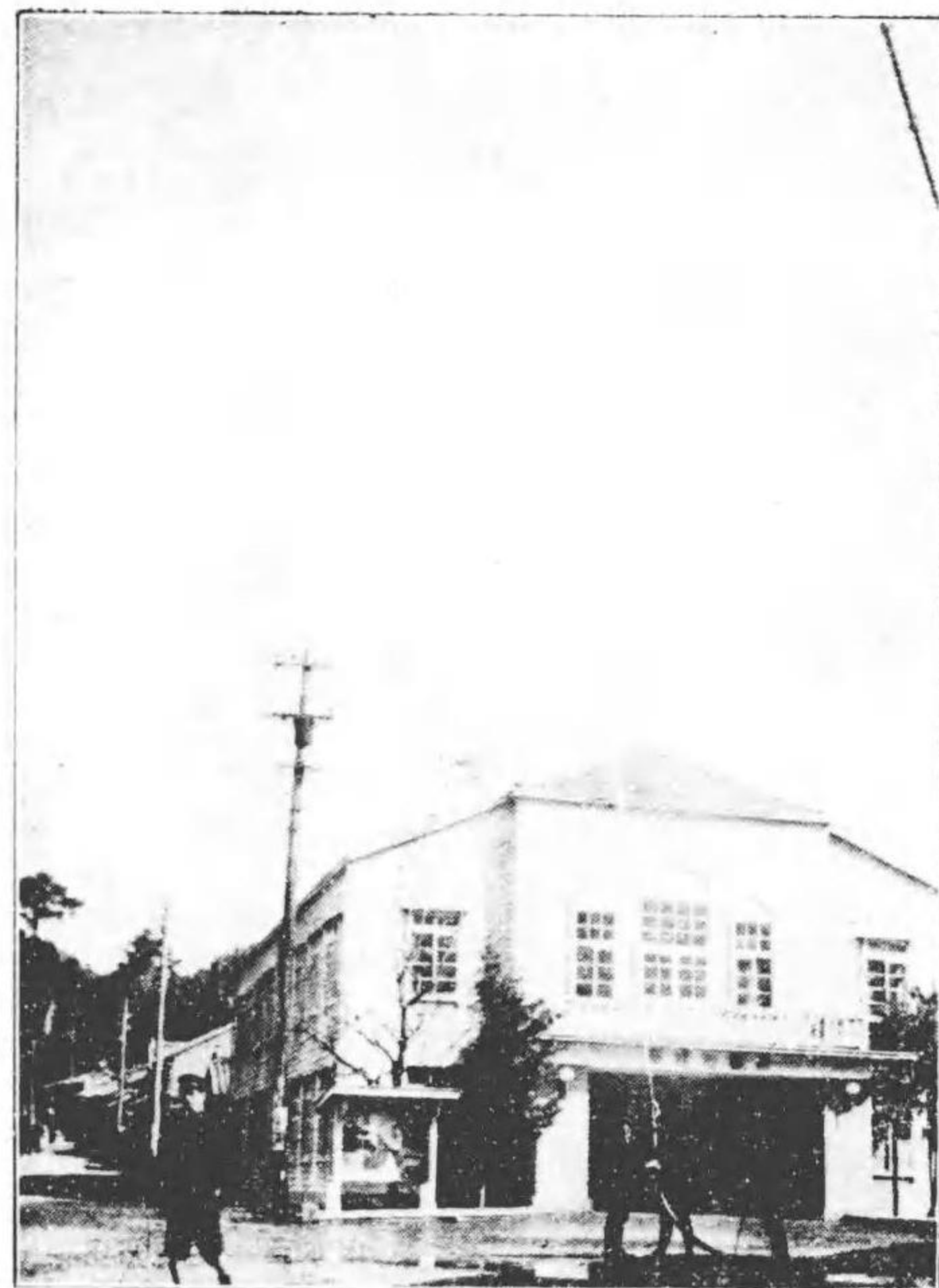
放水試験 (新宮町役場前)
